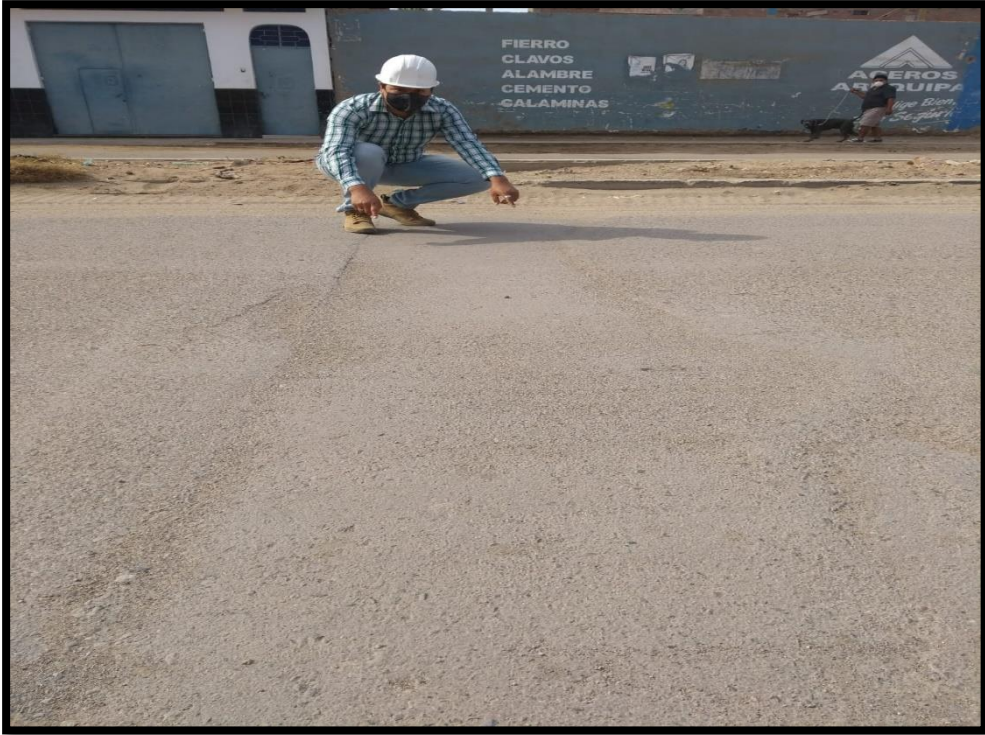
ILUSTRACIÓN 5: PARCHEO Y PULIMIENTO DE AGREGADOS
