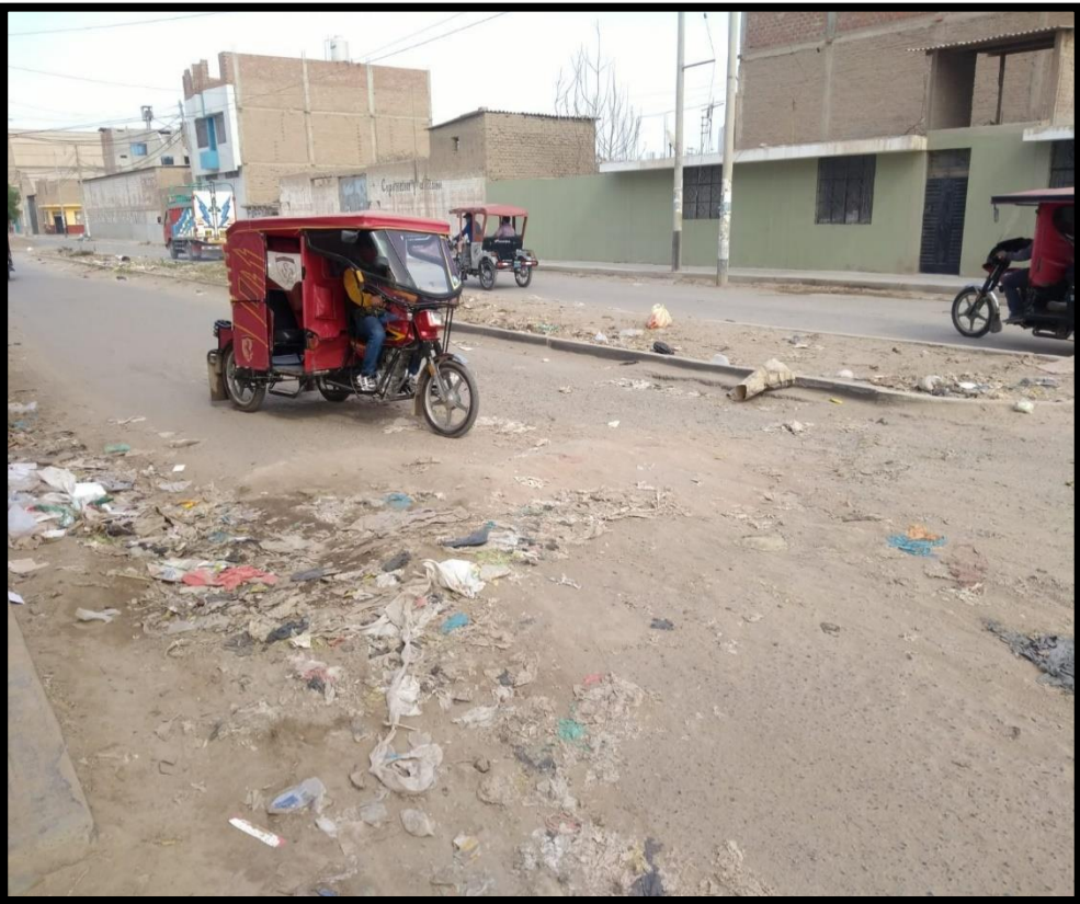
ILUSTRACIÓN 44: HUNDIMIENTO, PULIMIENTO DE AGREGADOS.
