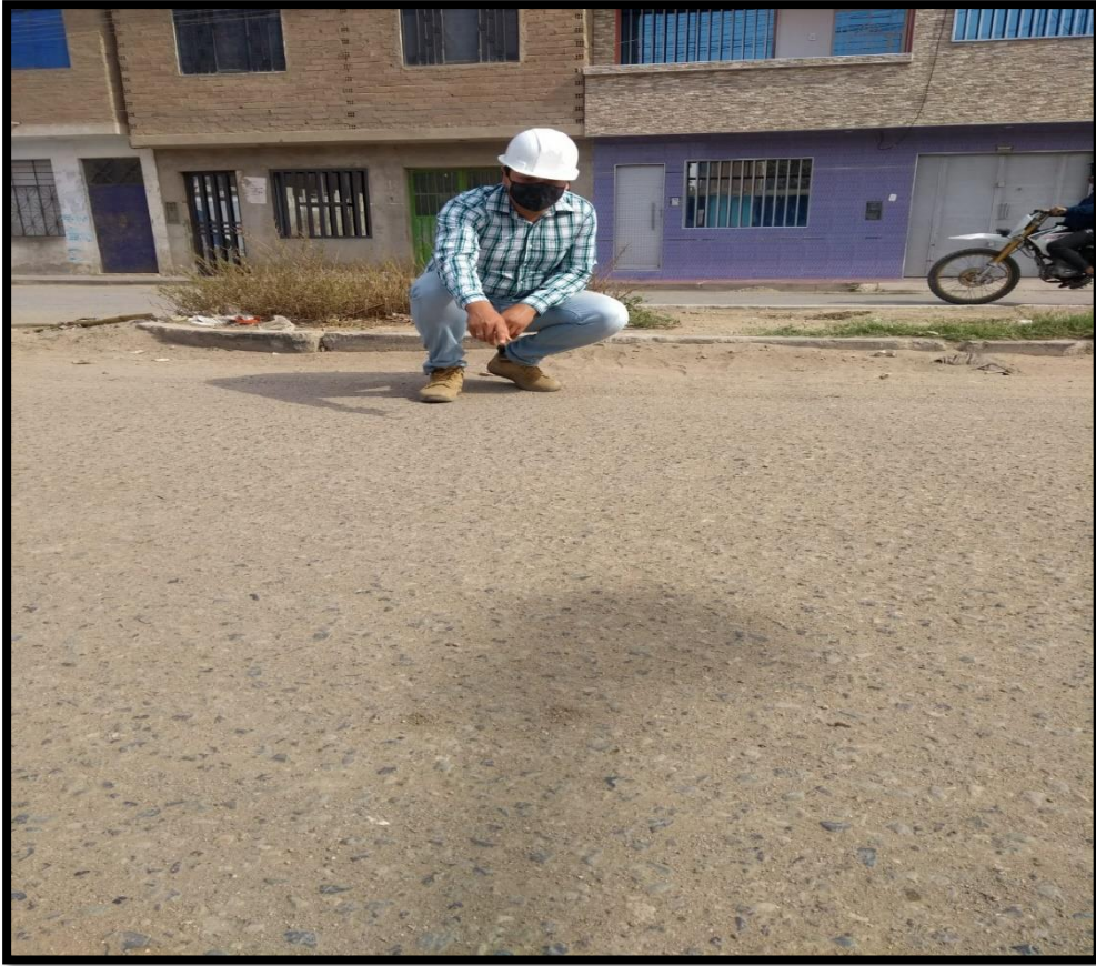
ILUSTRACIÓN 33: PULIMIENTO DE AGREGADOS.
