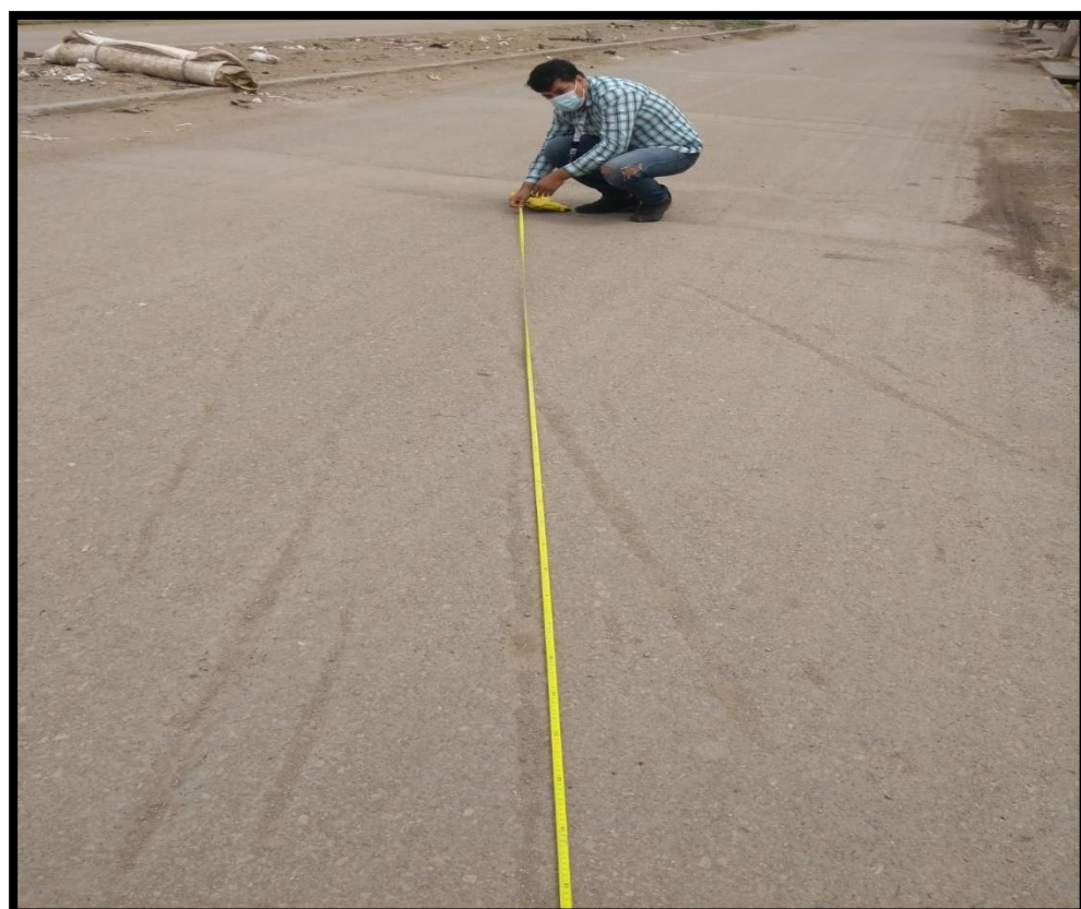
ILUSTRACIÓN 22: GRIETAS LONGITUDINALES.
