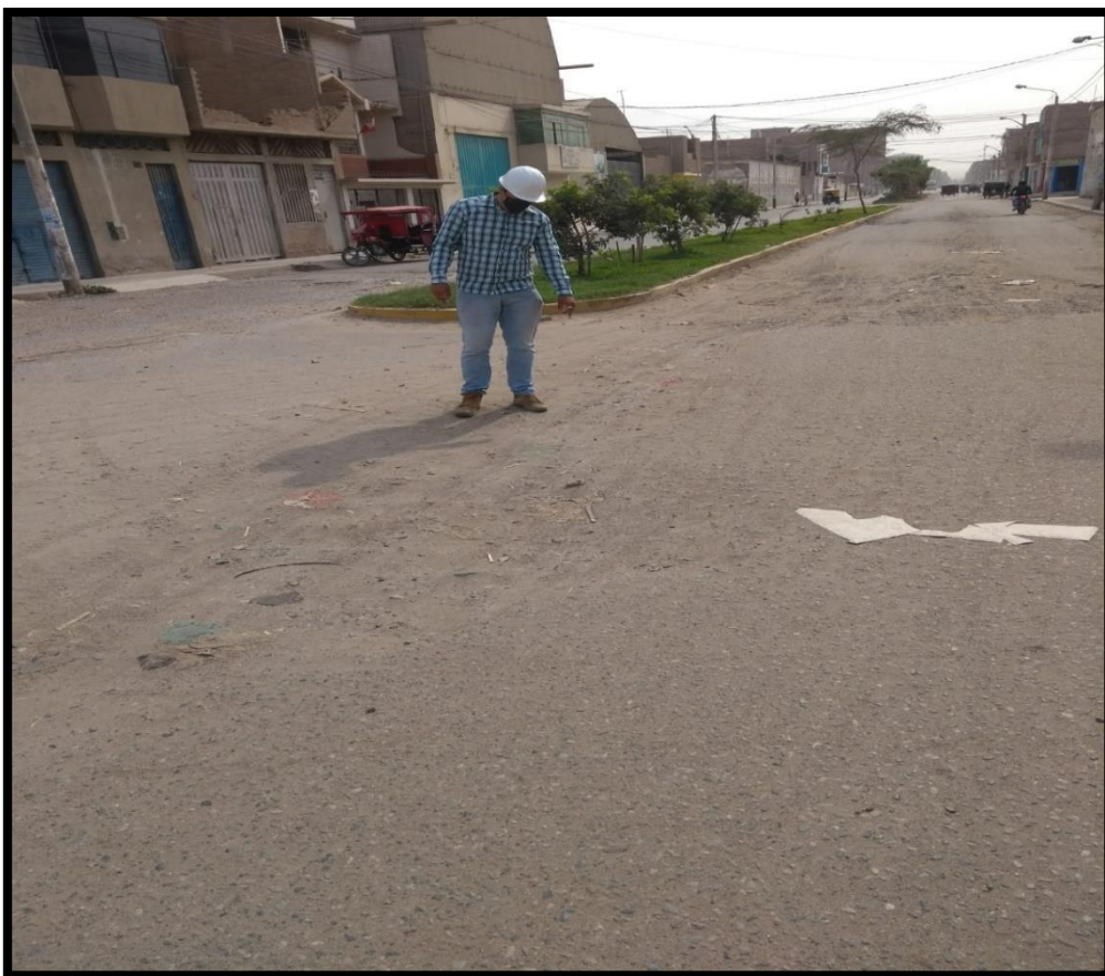
ILUSTRACIÓN 30: DESPRENDIMIENTO DE AGREGADOS, HUNDIMIENTO, PULIMIENTO DE AGREGADOS.
