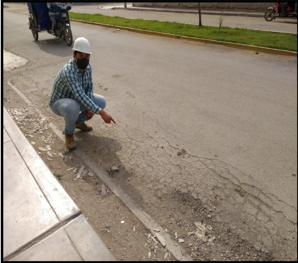
ILUSTRACIÓN 3: PIEL DE COCODRILO Y DESPRENDIMIENTO DE AGREGADOS
