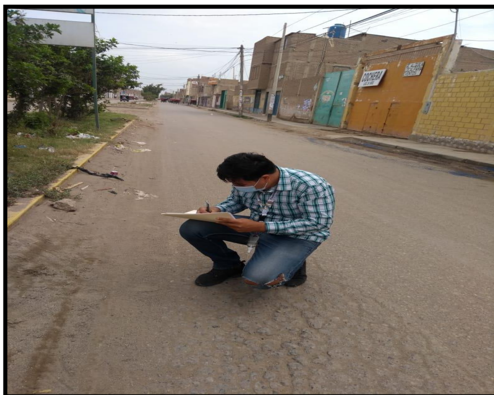
ILUSTRACIÓN 20: PIEL DE COCODRILO, AGRIETAMIENTO EN BLOQUE.
