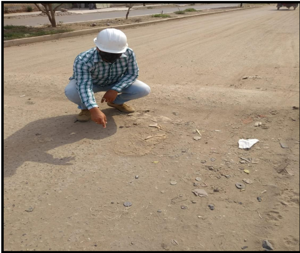
ILUSTRACIÓN 27: PULIMIENTO DE AGREGADOS.
