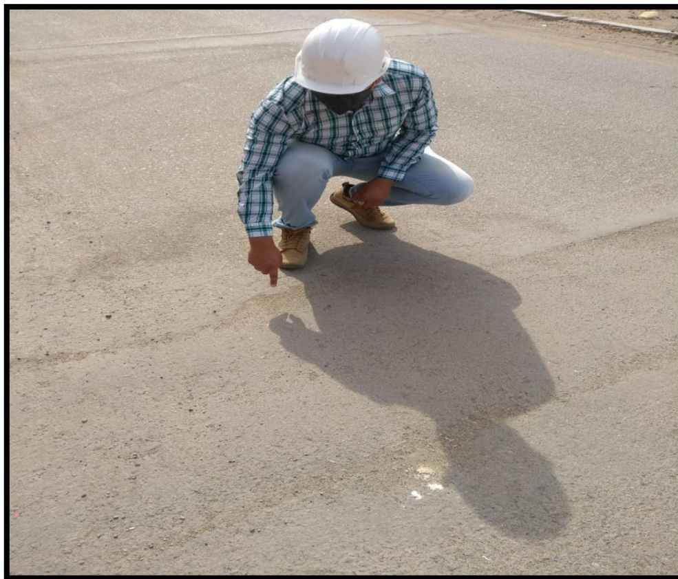
ILUSTRACIÓN 12: GRIETAS TRANSVERSALES.
