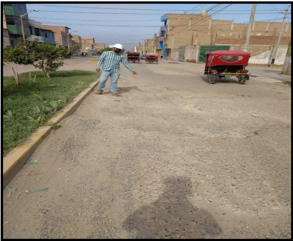
ILUSTRACIÓN 8: ABULTAMIENTOS Y HUNDIMIENTOS
