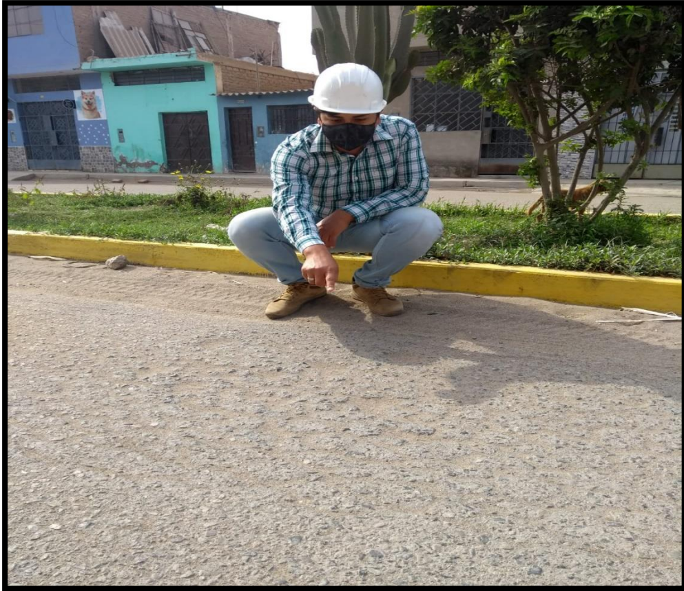
ILUSTRACIÓN 9: PULIMIENTO DE AGREGADOS
