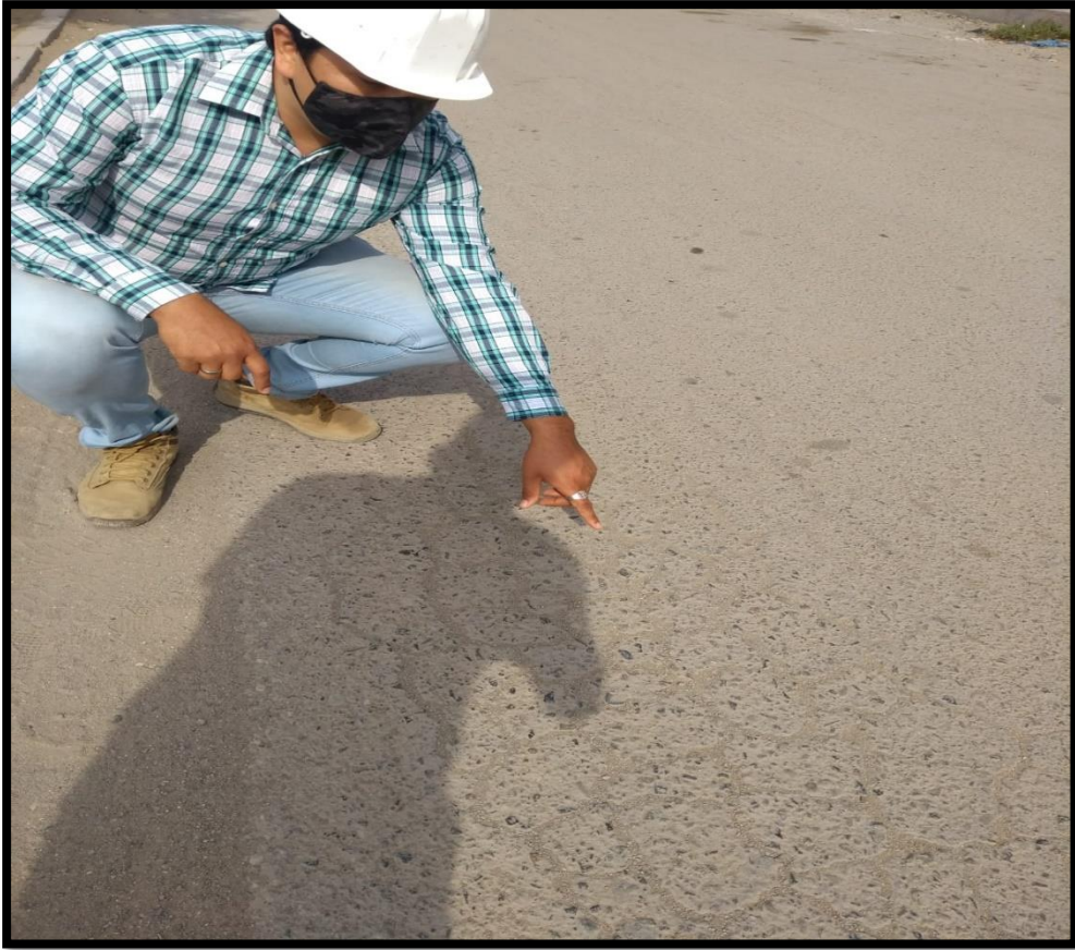
ILUSTRACIÓN 13: PULIMIENTO DE AGREGADOS
