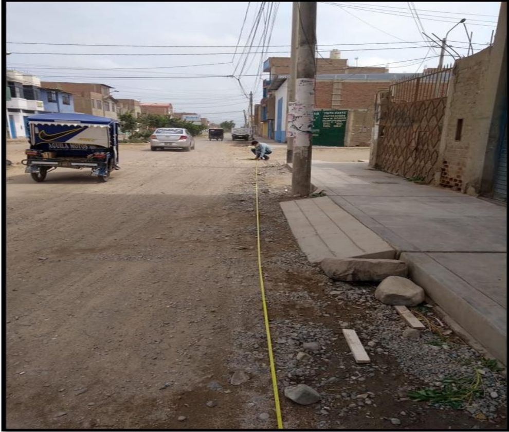
ILUSTRACIÓN 17: DESPRENDIMIENTO DE AGREGADOS.
