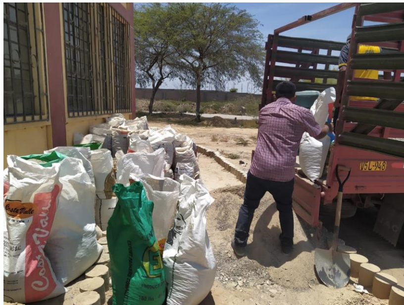
Figura 27. Transporte de materiales
