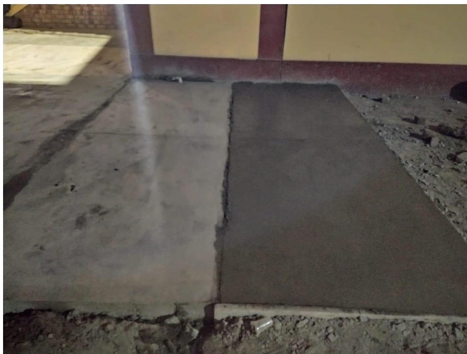
Figura 47. Losa con fibra
