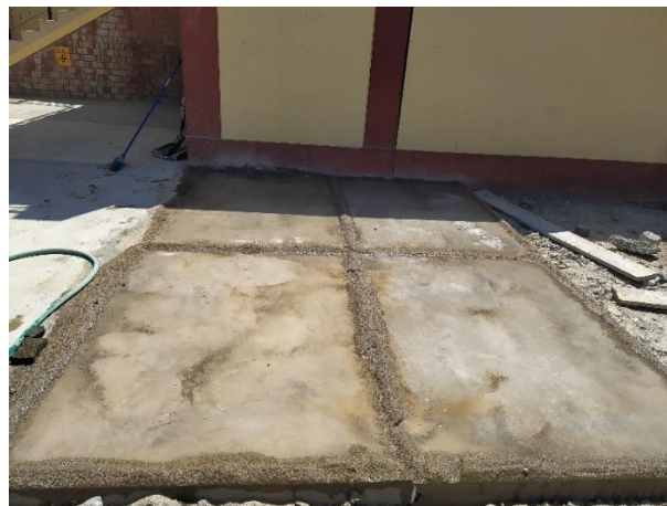
Figura 23. Curado de losas
