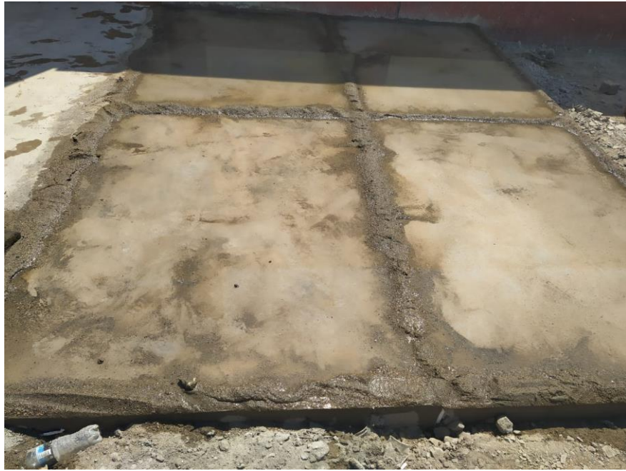
Figura 48. Curado de losa sin fibra y losa con fibra
