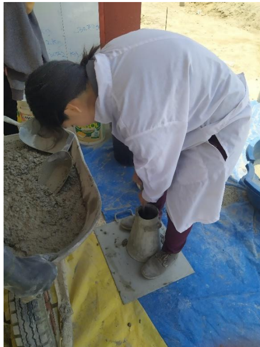
Figura 39. Ensayo de consistencia del concreto
