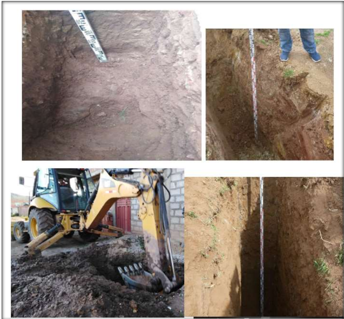
Gráfico 21: Extracción de muestra de suelo calicatas 1 y 2
