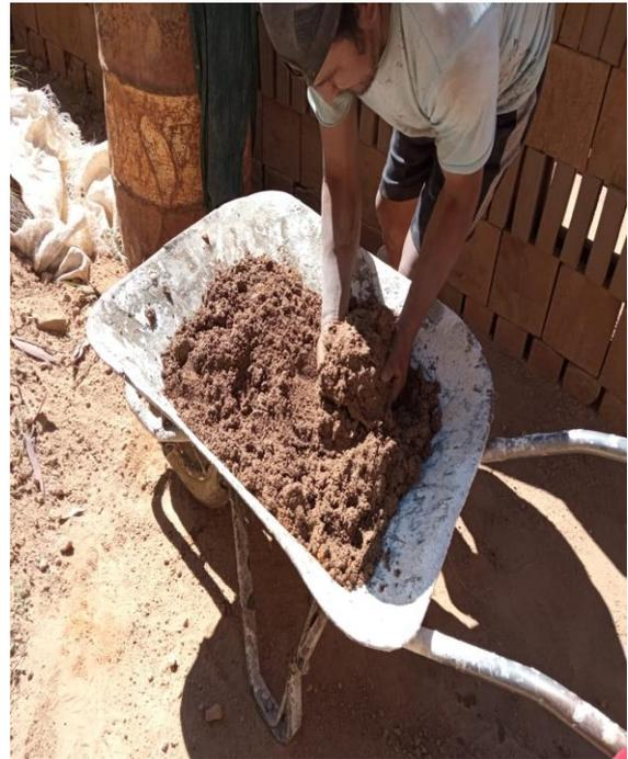
Fotografía 10. Se coloca la masa de tierra en la carretilla, para colocarlos en la adobera.
