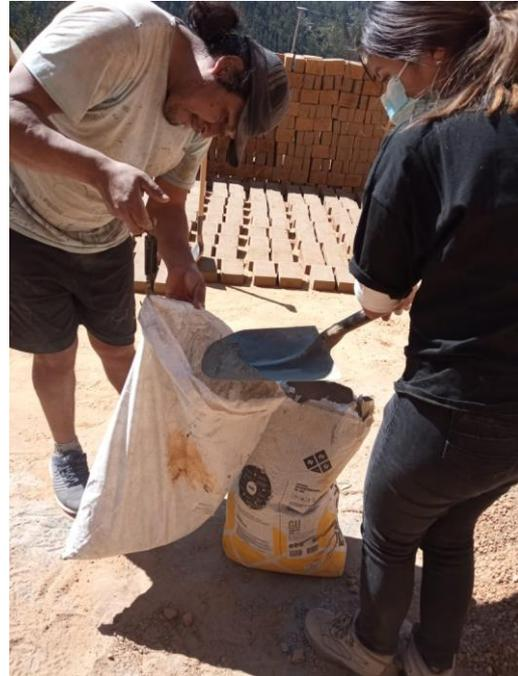
Fotografía 4. Se dosifica la cal y el cemento en función del peso total de la tierra.
