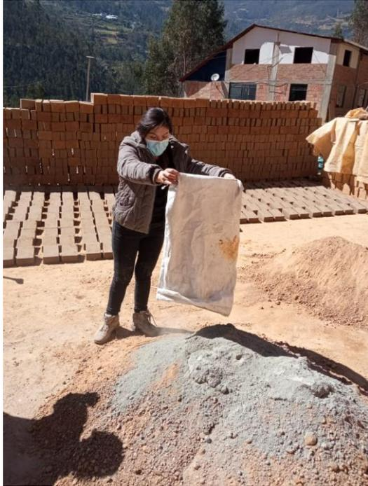
Fotografía 5. Se coloca la cal y el cemento en los 3 grupos de tierra formados.
