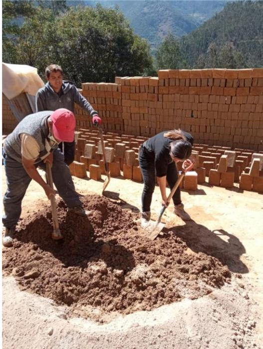
Fotografía 9. Se mezcla la masa de la tierra, el cemento, la cal y el agua.
