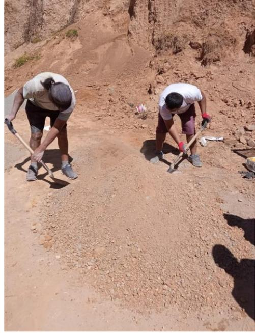
Fotografía 2. Mezclado de las dos tipos de tierra una se usó el 75% y la otra tierra solo el 25%.
