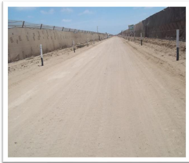
Figura 1: Vía afirmada sin Cloruro de Calcio
