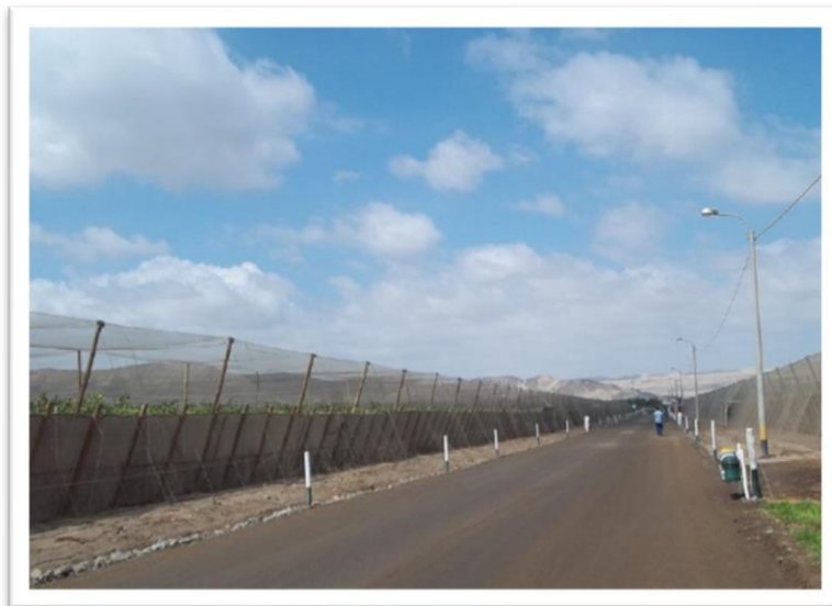
Figura 2: Vía afirmada con Cloruro de Calcio
