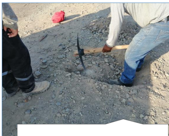
Fotografía N° 03: Excavacion Calicata 01
