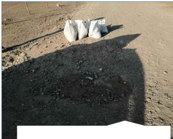
Fotografía N° 05: Sellado de Calicata 01
