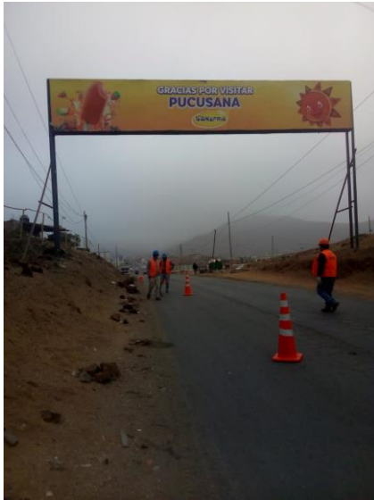
Fotografía 7. Señalización del área de trabajo
