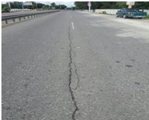
Figura 5. Fisura Longitudinal
