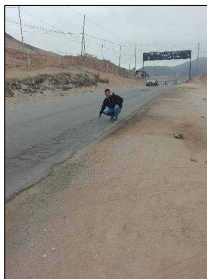
Figura 2. Reconocimiento de fallas
