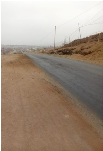
Fotografía 3. Pavimento a evaluar
