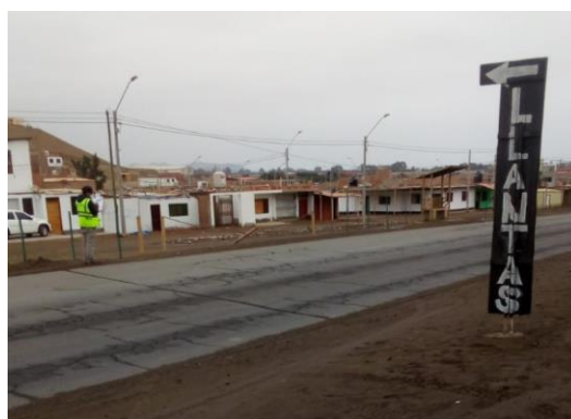
Figura 18. Toma de datos de fallas
