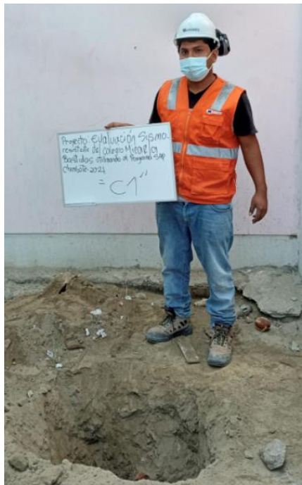
Foto N° 01: Excavación de la calicata C-1
