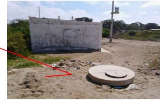
CASETA DE BOMBEO EPS EPSDEL S.A.
