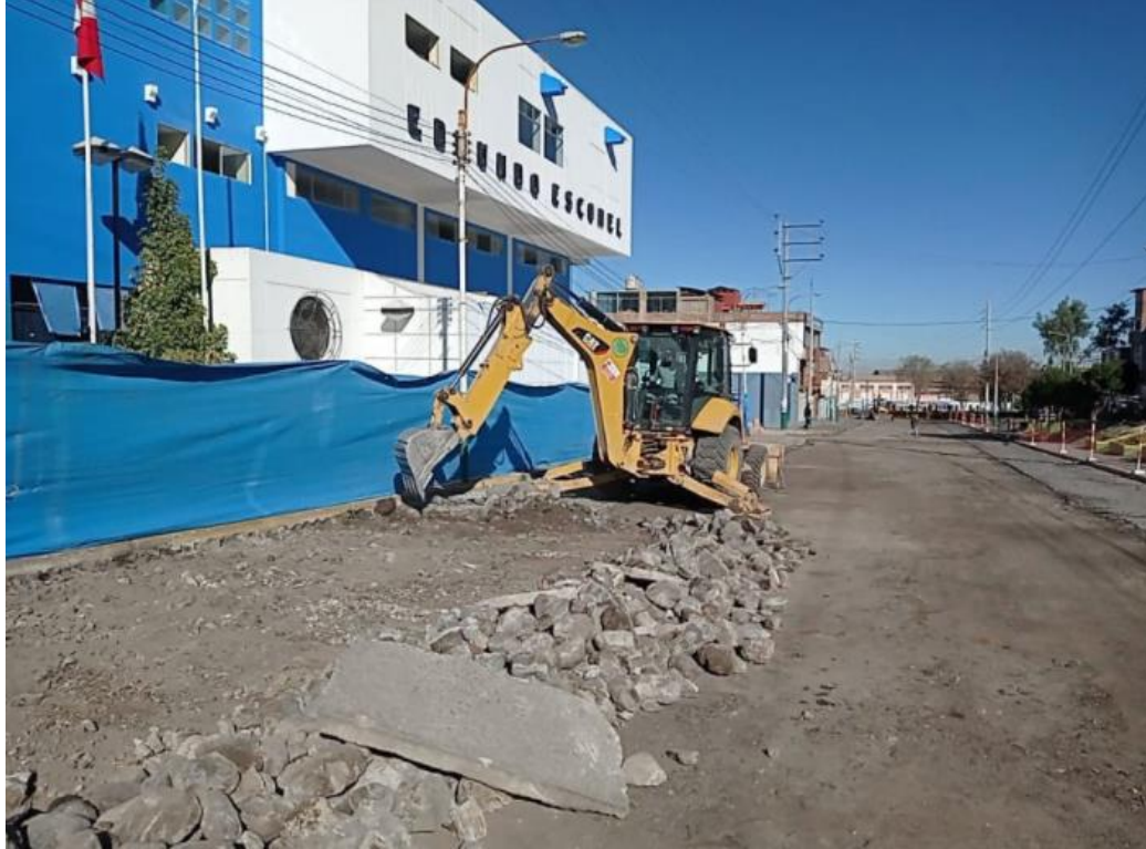
Figura 14. Demolición de la berma.
