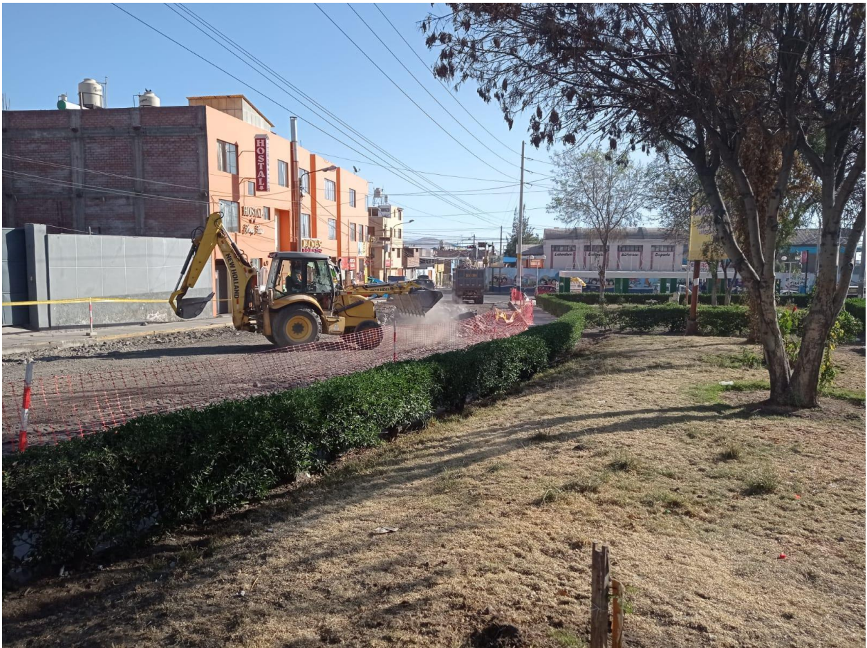
Figura 22. Eliminación de material con maquinaria. Fuente propia.
