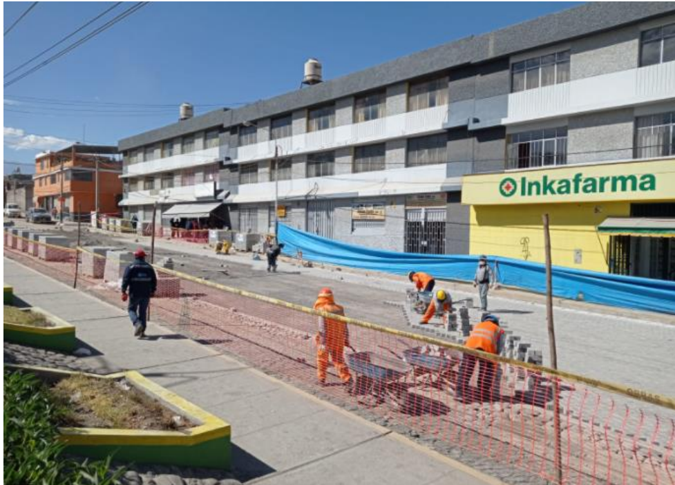
Figura 13. Colocación de adoquín en la calzada.
