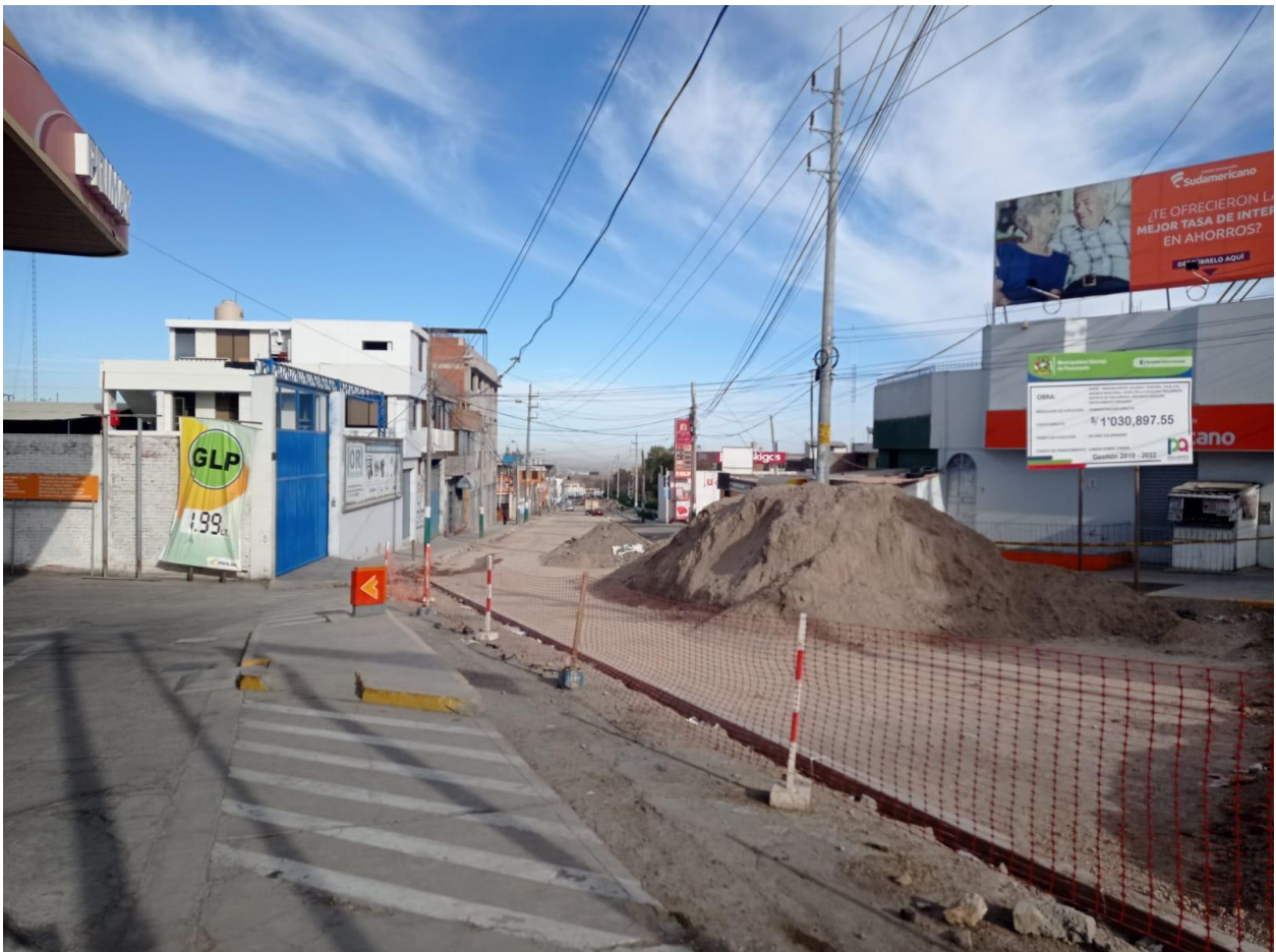
Figura 23. Material Base puesto en obra. Fuente propia.
