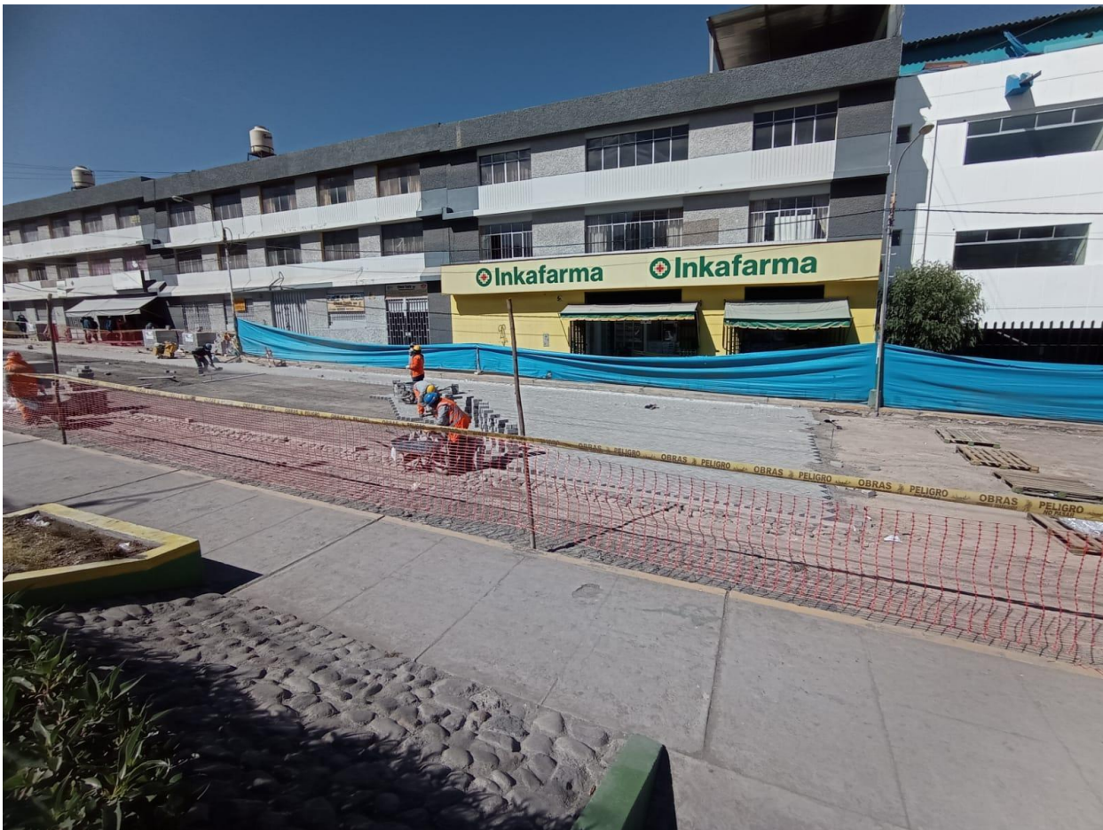
Figura 25. En la figura observamos el colocado de la cama de arena.
