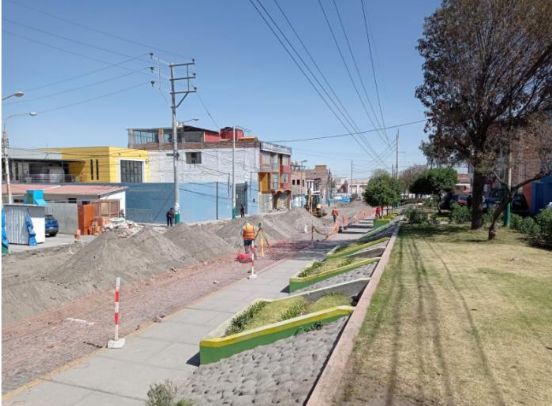
Figura 12. Obra en etapa de ejecución.
