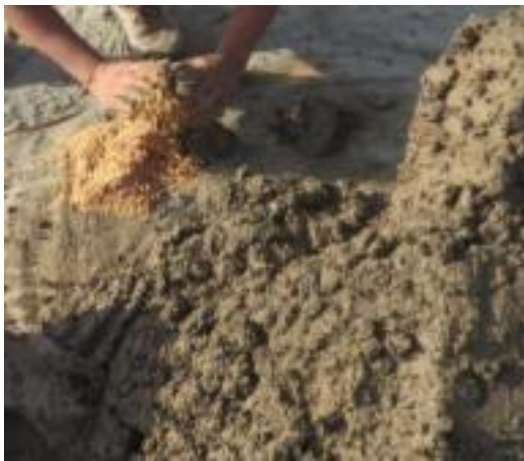
FOTOGRAFIA 3 y 4. Incorporación del aserrín a la mezcla de barro.
