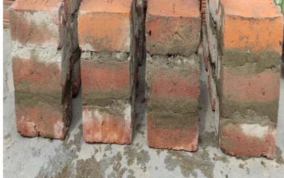
Figura 13. pilas de ladrillo con la dosificación de aserrín.
