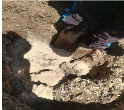
FOTOGRAFIA 3 y 4. Incorporación del aserrín a la mezcla de barro.
