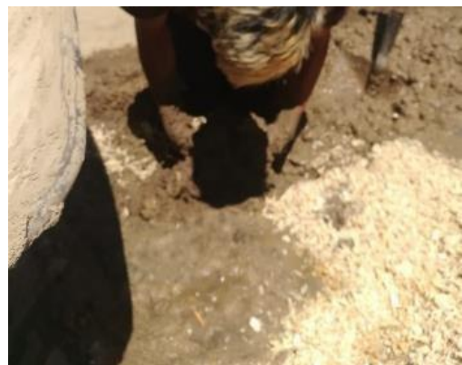
FOTOGRAFIA 3 y 4. Incorporación del aserrín a la mezcla de barro.
