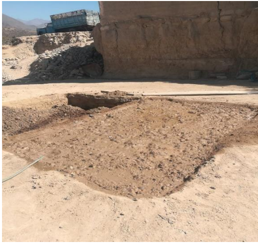
FOTOGRAFIA 7 y 8. Proceso de maduración de la mezcla durante 24h.
