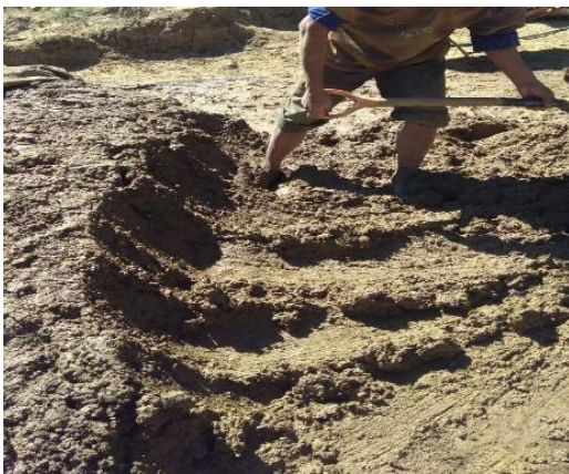
FOTOGRAFIA 5 y 6. Mezcla con pala y mano, hasta obtener una mezcla homogénea con el aserrín.
