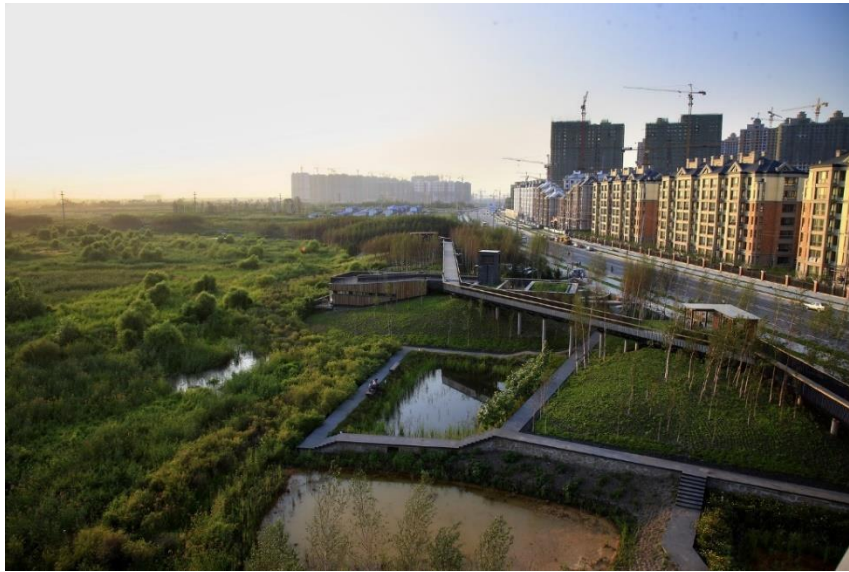
Figura 13. El núcleo natural central se mantiene intacto, sólo se intervino el aro exterior
