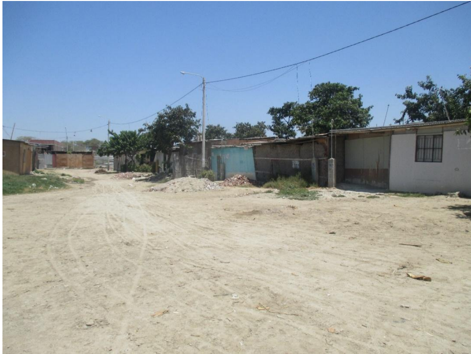
Figura 32. Pasaje 1: Existencia de postes de alumbrado público y presencia de botaderos
