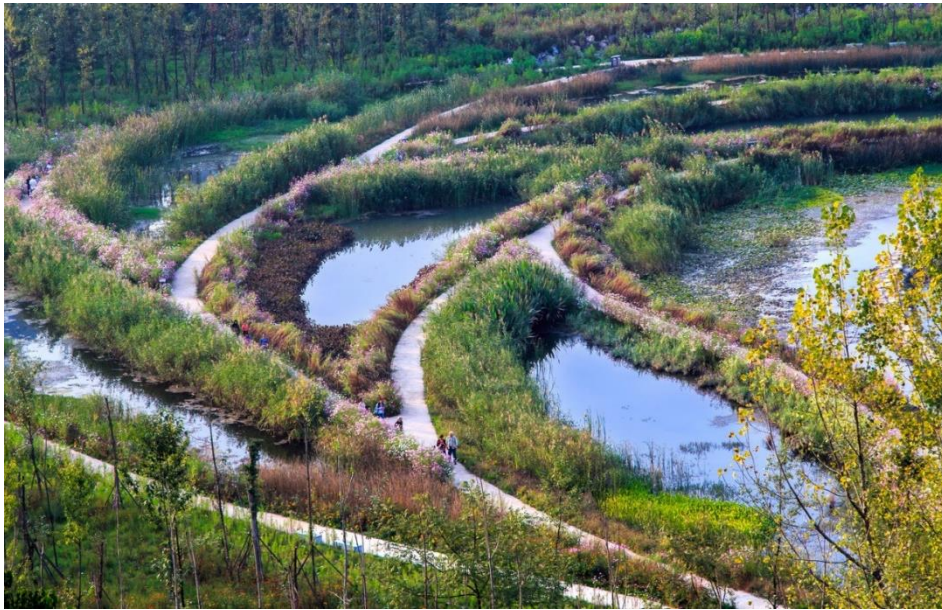
Figura 3. humedales en terrazas y sembrado de vegetación nativa fitodepuradora
