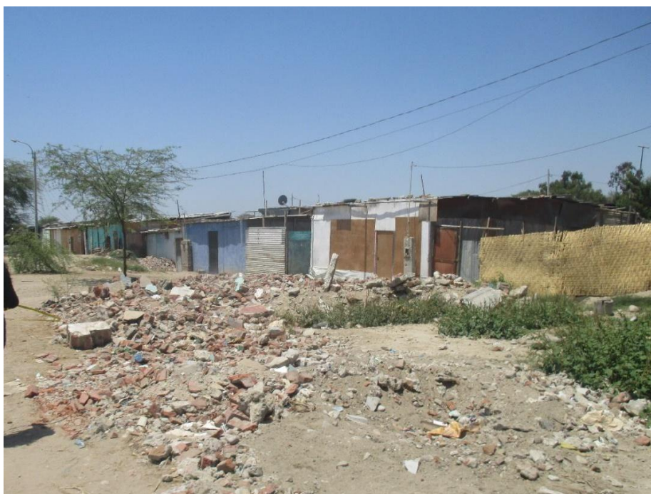
Figura 30. Calle 4: Existencia de postes de alumbrado público y presencia de botaderos
