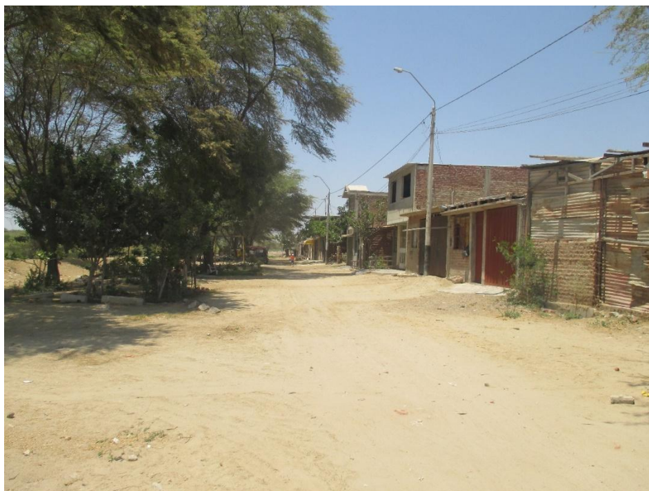
Figura 31. Pasaje D: Existencia de postes de alumbrado público
