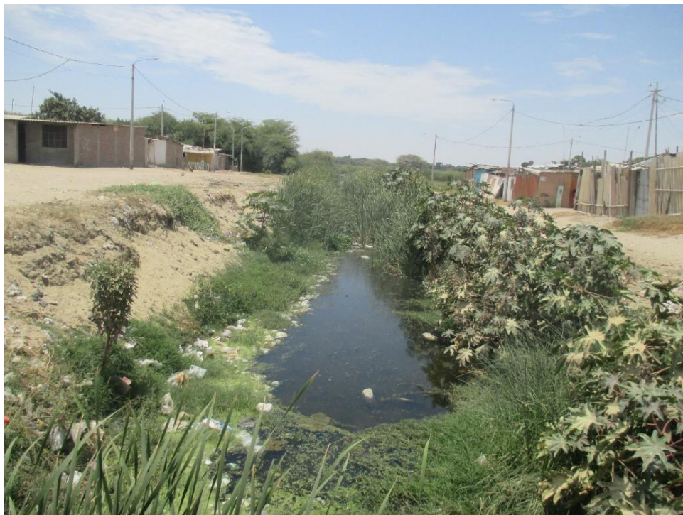
Figura 33. Estado de Dren Japón en la Calle 1 y postes de alumbrado público existentes.
