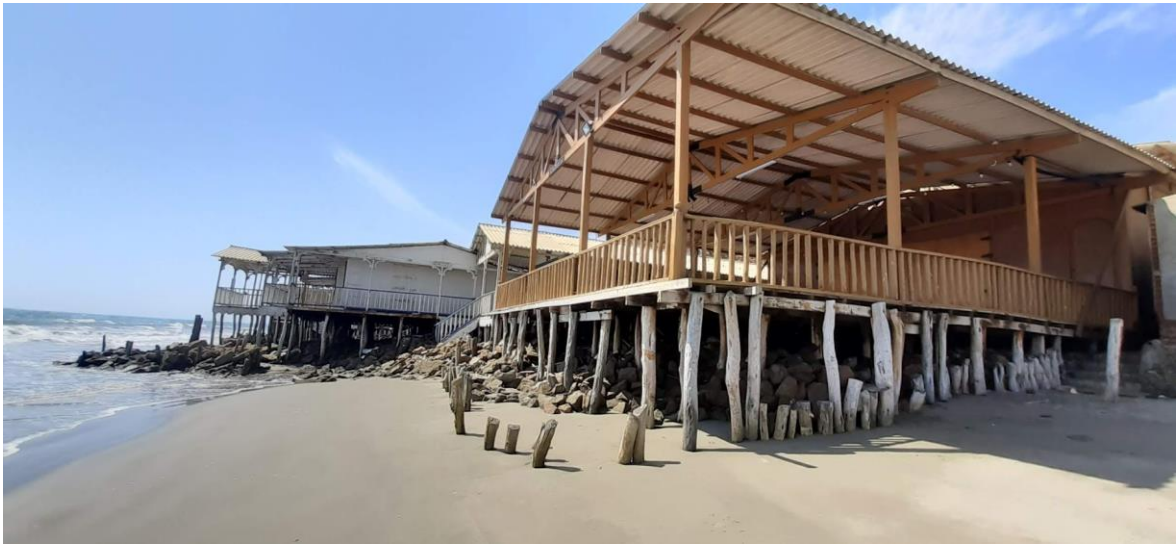
Figura 08: Vivienda de madera con terraza, lado norte.
