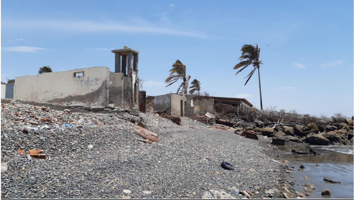
Figura 10: Vivienda de material noble, afectada por oleajes anómalos.
