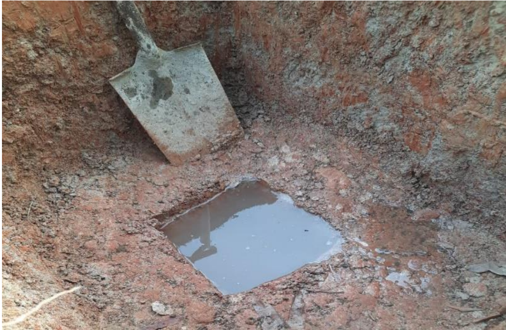
Se muestra las excavaciones realizadas para el tes de percolación
