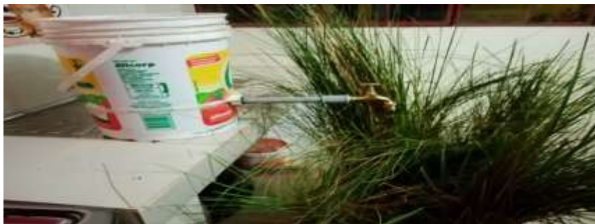
Figura 7. Tratamiento de aguas servidas mediante el humedal artificial Waylla Ichu
