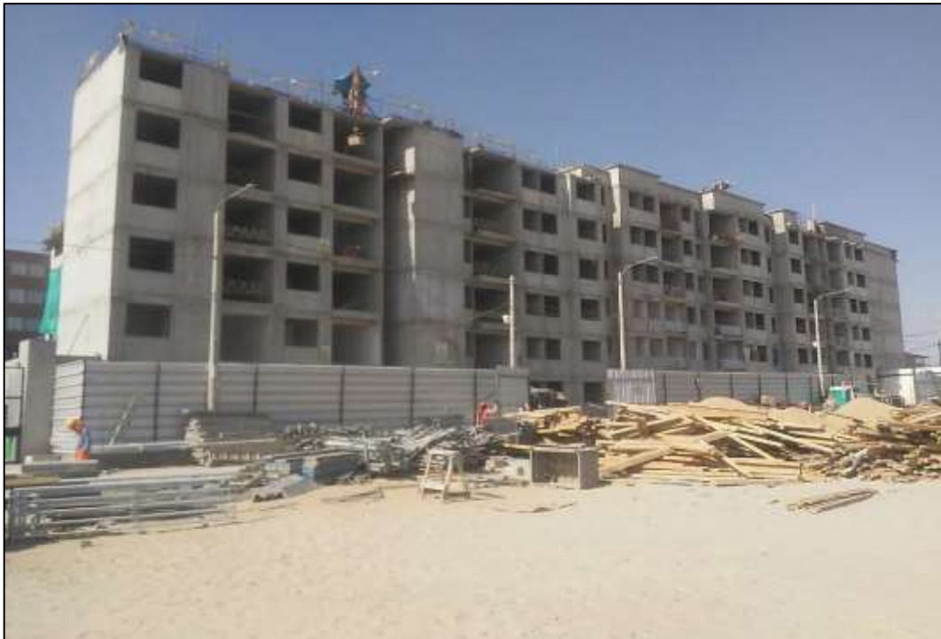
Torre 3 y 4 - II Etapa, en proceso de acabados.
