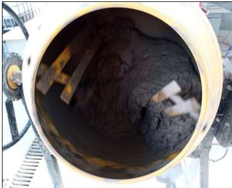
Fotografía n.º 08. Mezclado del concreto autocompactante.
