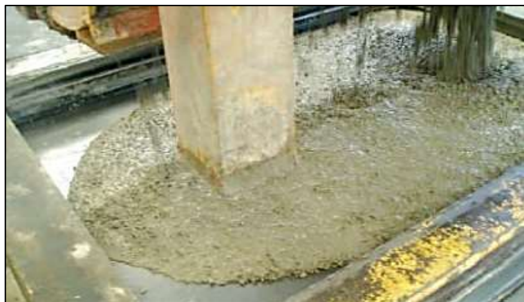
Gráfico 2. Vaciado de hormigón autocompactante (HAC).
