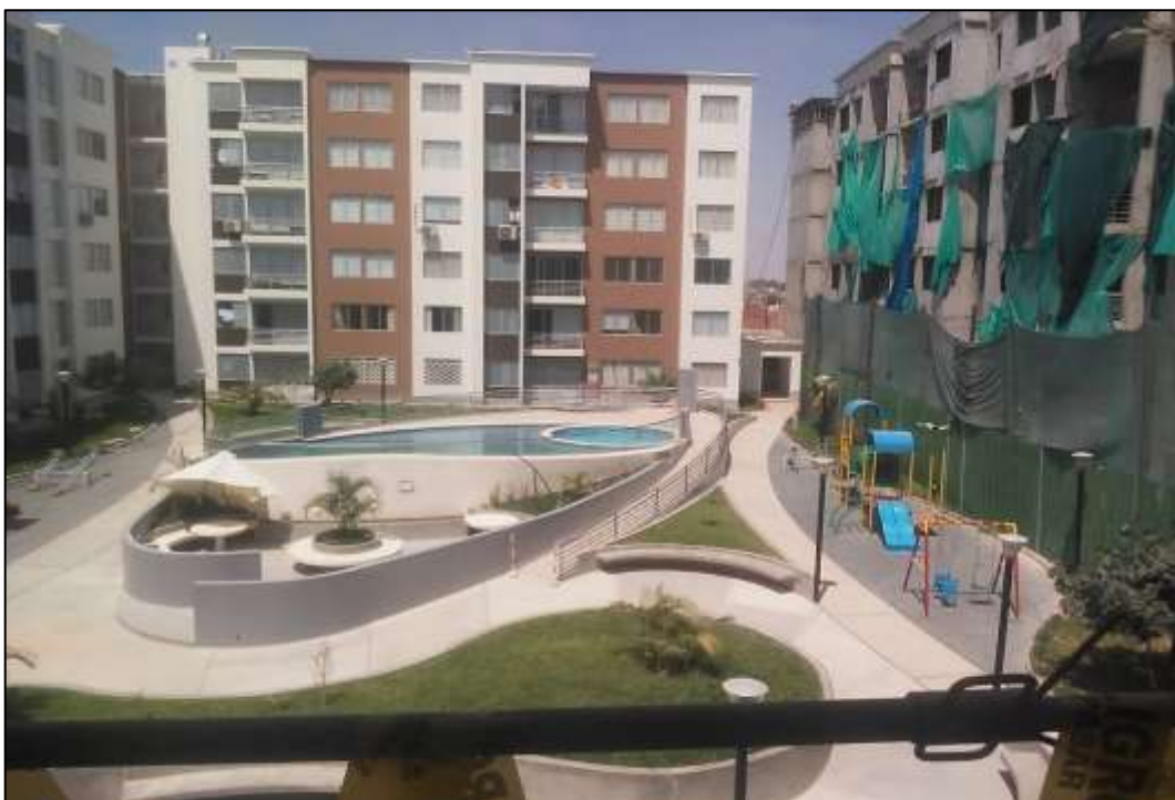
Imagen 02: Conjunto residencial - I y II Etapa.
