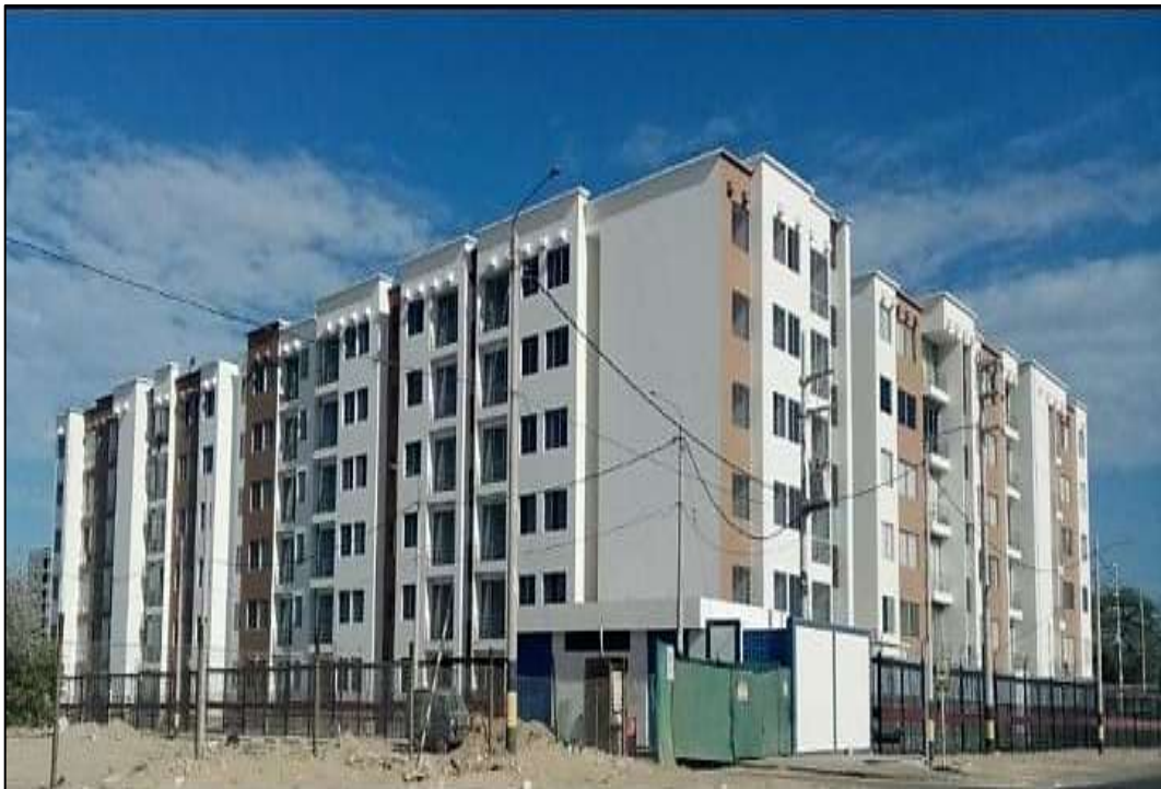
Imagen 04. Edificios multifamiliares terminados.
