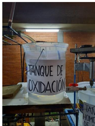
Figura 22. Tanque de Oxidación
