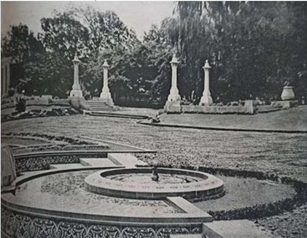
Figura 66 Surtidor del lado este, Fuente Sevillana
