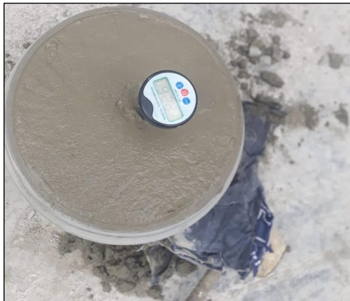
Figura 52. Lectura de temperatura, ensayo NTP 339.184.
