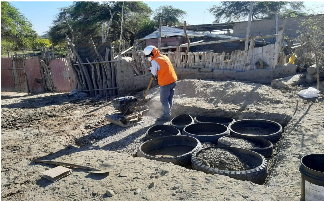
Figura 28. Relleno y compactado para método tradicional.
