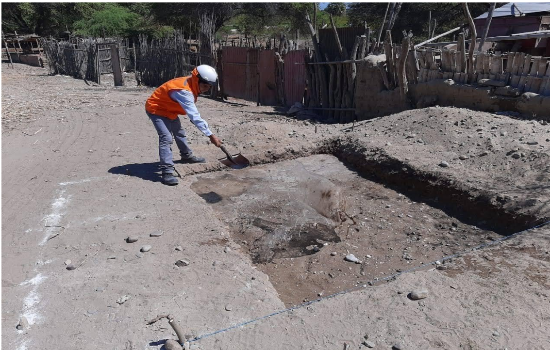
Figura 22. Regado de subrasante para Compactar.
