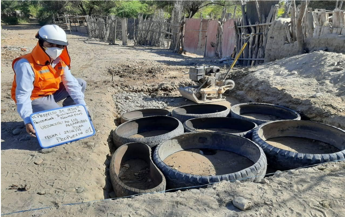
Figura 25. Colocación y Distribución de Neumáticos a Nivel de Subrasante en un área de 2 \times 2 \text{ m}^2
