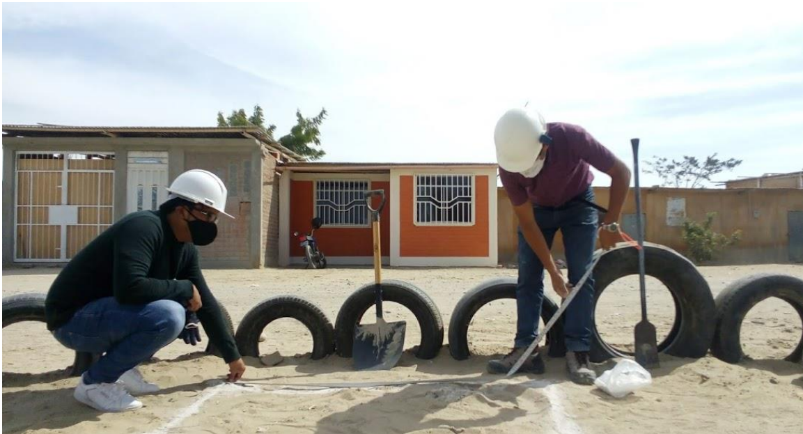
Figura 9. Nivelación y trazados del área para realizar la excavación en la prueba de campo.
