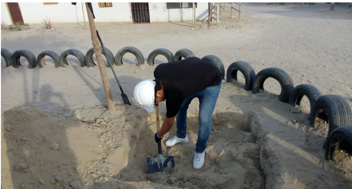
Figura 10. Excavación de un hoyo cuadrado de 1.5x1.5 metros y una altura de 25 cm.
