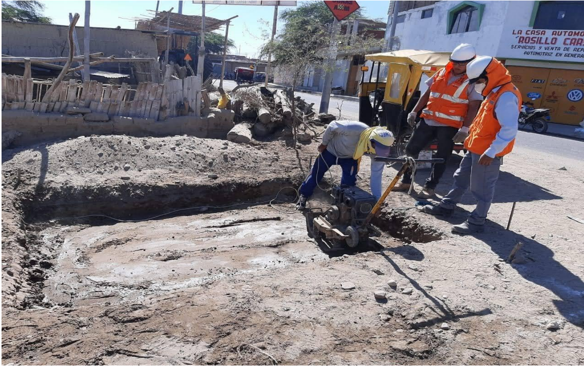
Figura 23. Compactado de Subrasante con Plancha Compactadora.
