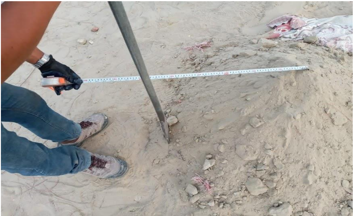
Figura 16. Medida del material sobrante en forma de cono utilizando la guincha metálica y una barra metálica.
