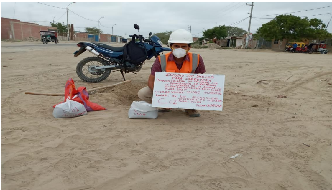
Figura 4: Calicata N° 2 – Progresiva 2+300
