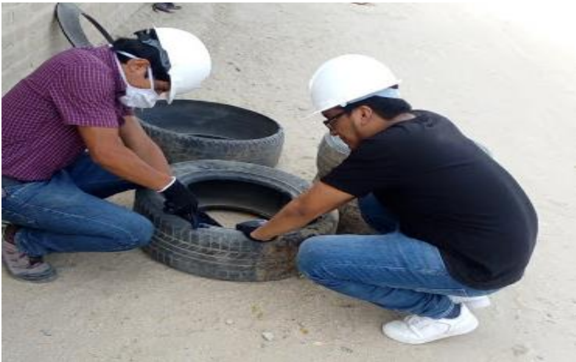
Figura 12. Fabricación del geocilindro de neumático, para ello se cortó Lo hombros o paredes laterales de los neumáticos.
