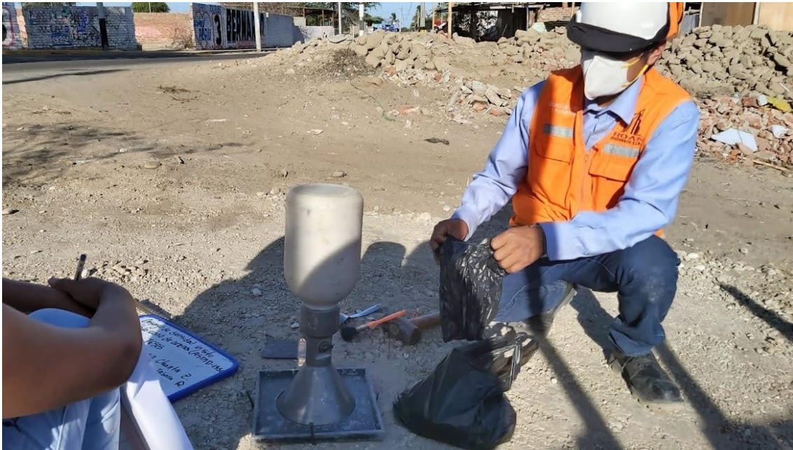
Figura 31. Realizando Ensayo de Densidad número 3 en la capa base e=0.10\text{m} .
