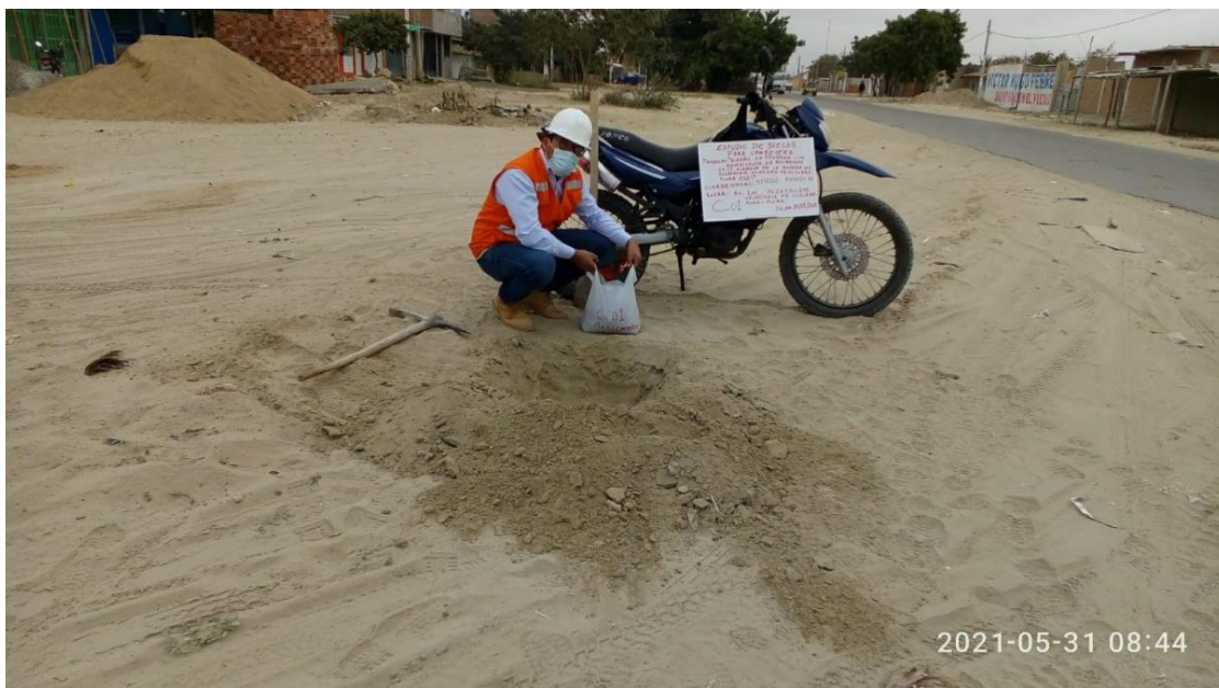
Figura 3: Calicata N° 1 – Progresiva 1+800
