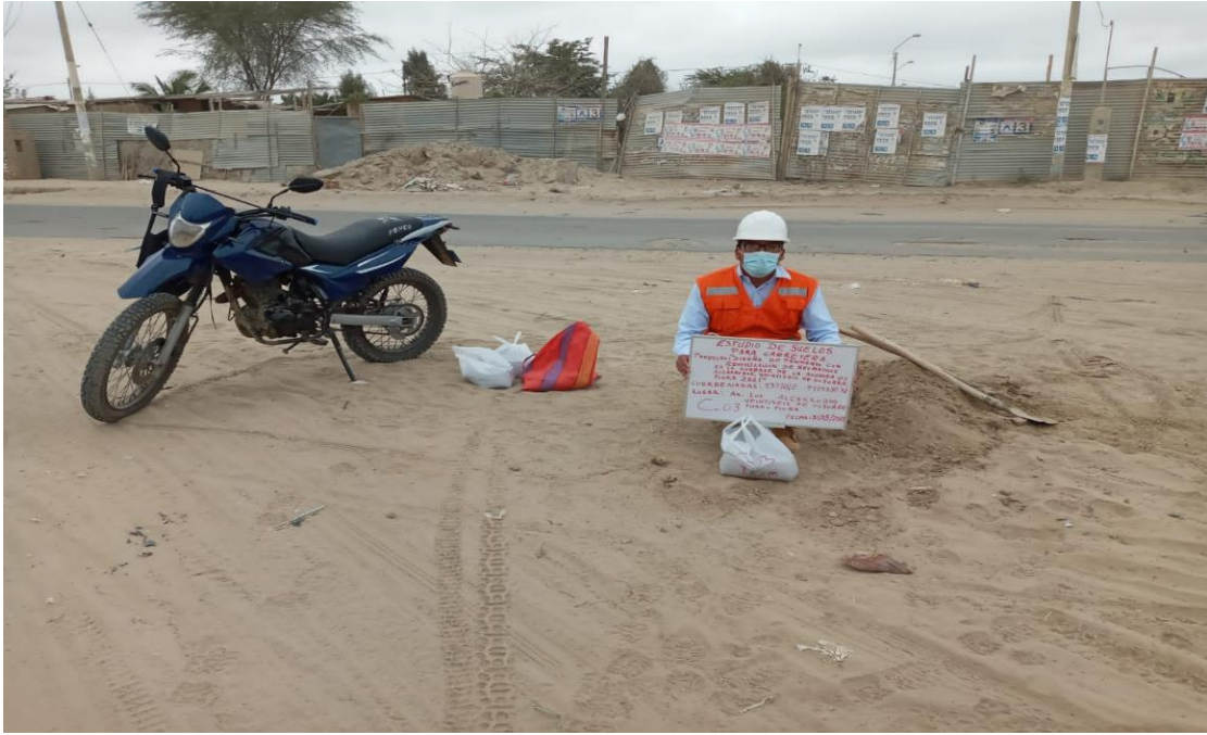
Figura 5: Calicata N° 3 – Progresiva 3+020
