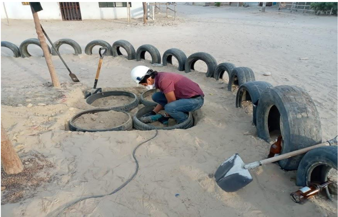
Figura 14. Colocación de un tornillo de cobre de 2 pulgadas para evitar que haya separación entre neumáticos.
