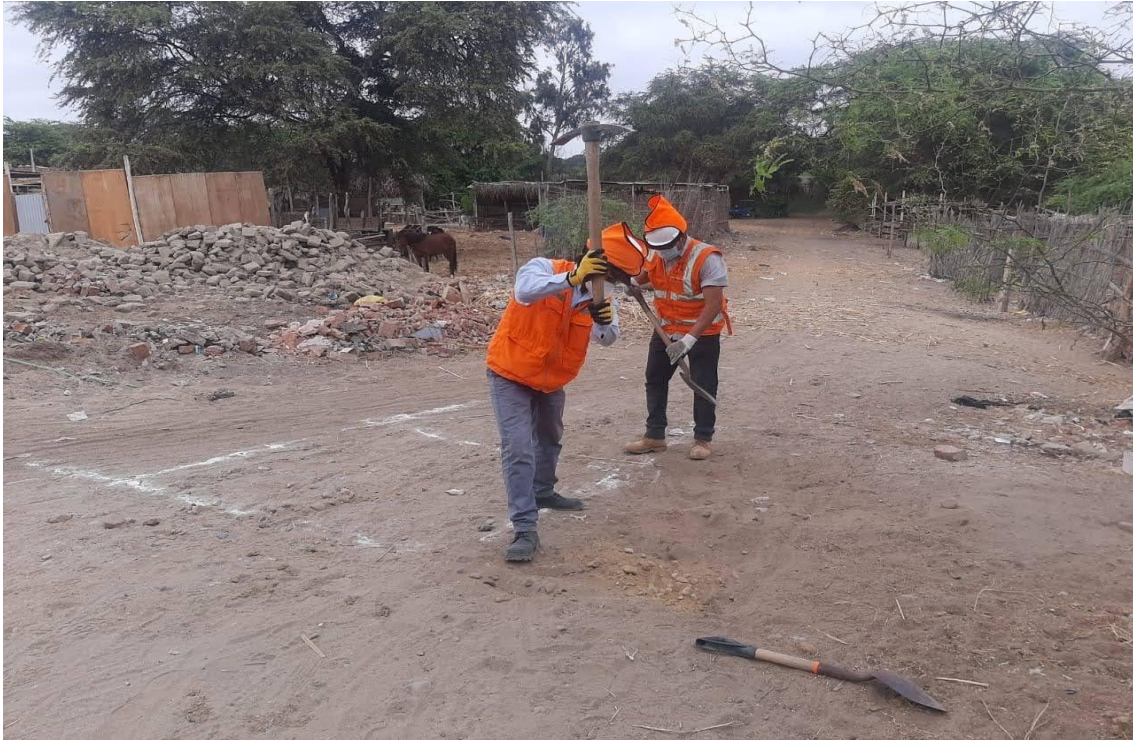
Figura 19. Corte de Material de forma Manual a Nivel de Subrasante.
