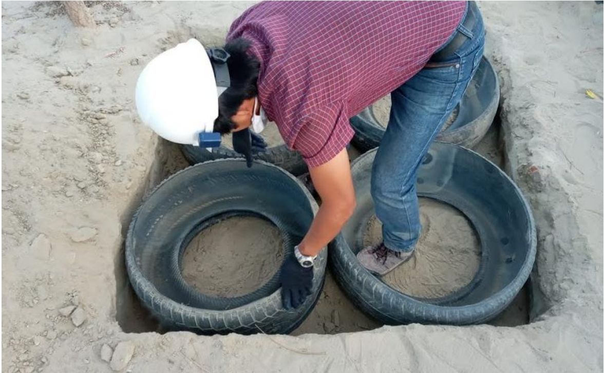
Figura 13. Colocación de los neumáticos en la excavación para luego ser llenados con el material extraído.
