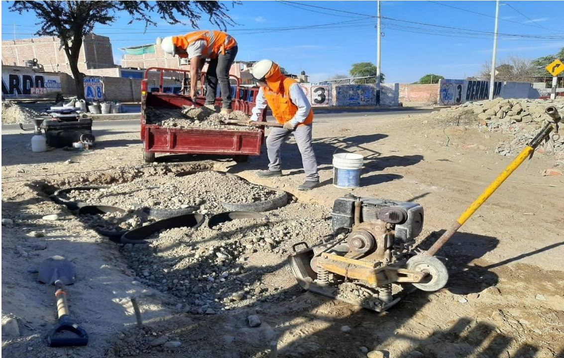
Figura 27. Relleno de afirmado en neumáticos como geocilindro y compactado.
