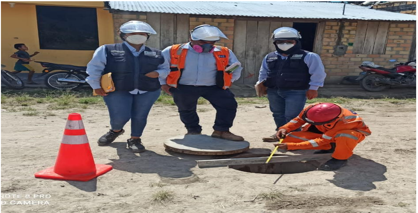
Se observa realizando la prueba de estanquidad para determinar si el proceso constructivo del buzón prefabricado se realizó con éxito.
