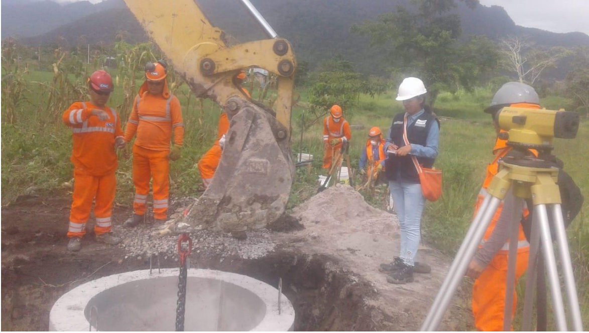
Se observa el proceso constructivo para calcular el rendimiento.
