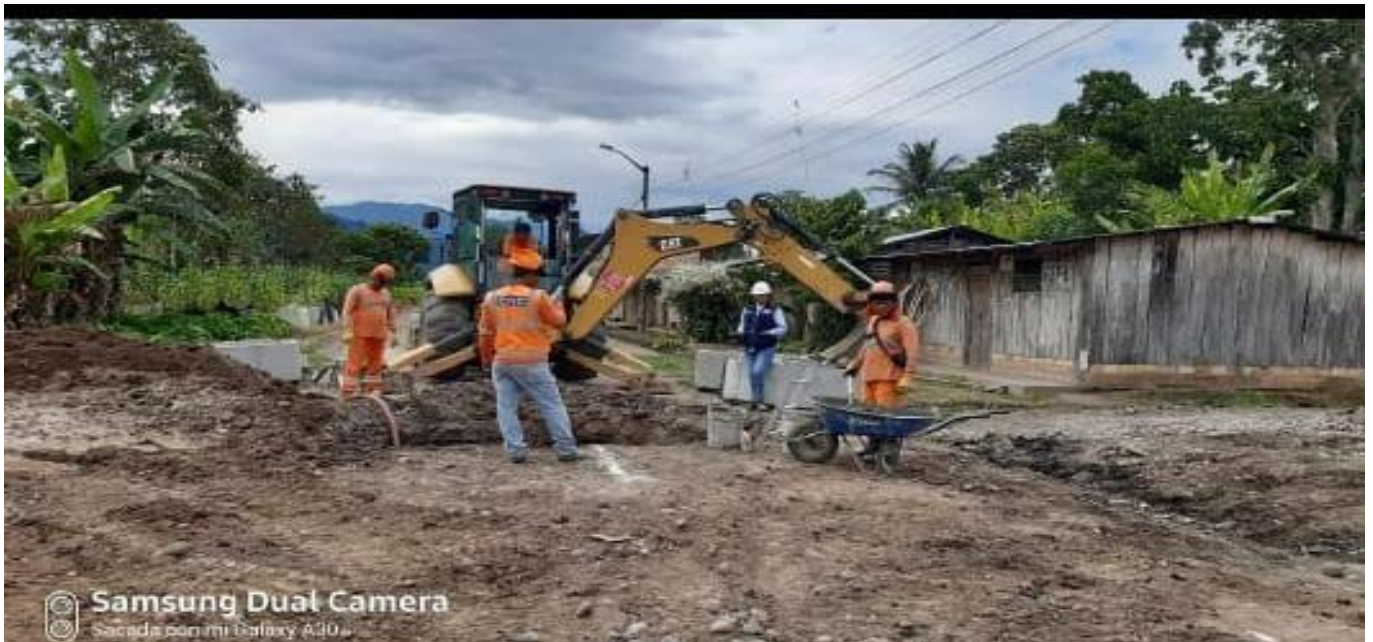
Se observa la excavación para la instalación de un buzón prefabricado donde se obtuvieron los tiempos de cada actividad.
