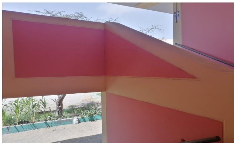
Figura N° 23. Escalera Bloque D del I.E. Fe y Alegría N°14
