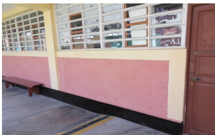
Figura N° 9. Vigas de Confinamiento – Pabellón D
