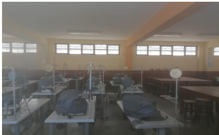
Figura N° 22. Losa aligerada Bloque E - I.E. Fe y Alegría N°14
