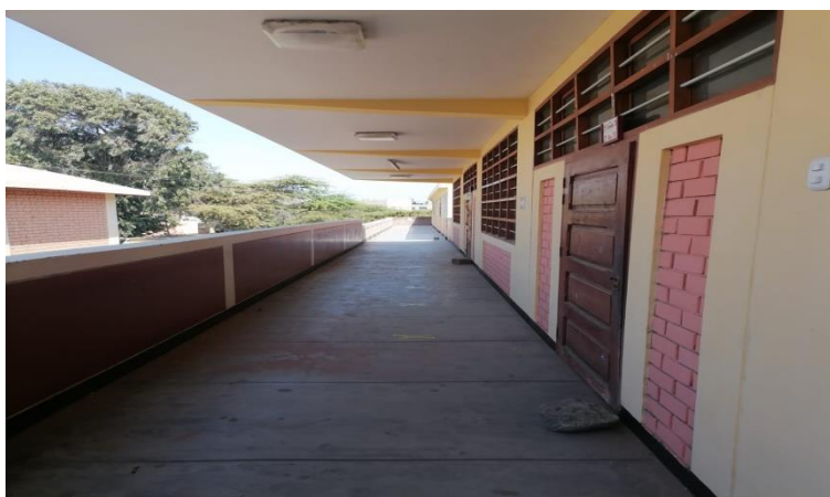
Figura N° 24. Voladizo Bloque D del I.E. Fe y Alegría N°14
