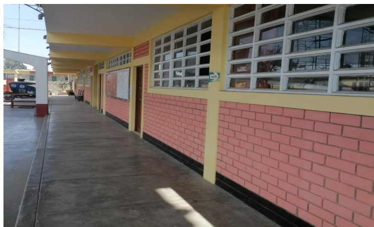
Figura N° 8. Vigas de Confinamiento – Pabellón A
