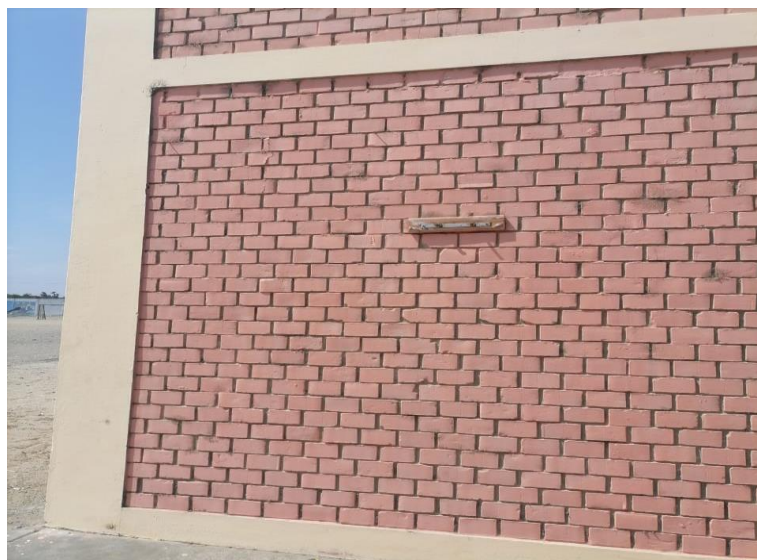
Figura N° 20..Muro del bloque A - I.E. Fe y Alegría N°14
