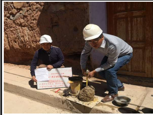
Figura 9. asentamiento del concreto f'c= 210 \text{ kg/cm}^2 con 0.10% de fibra sintética
