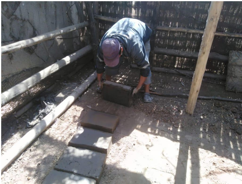
Figura N°9: Desmoldado de los adobes patrón.
