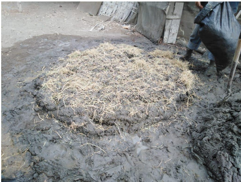
Figura N°16: Mezclado del adobe experimental con 10% de paja de arroz.
