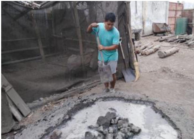
Figura N°4: Mezclado de la tierra con agua para el adobe patrón.
