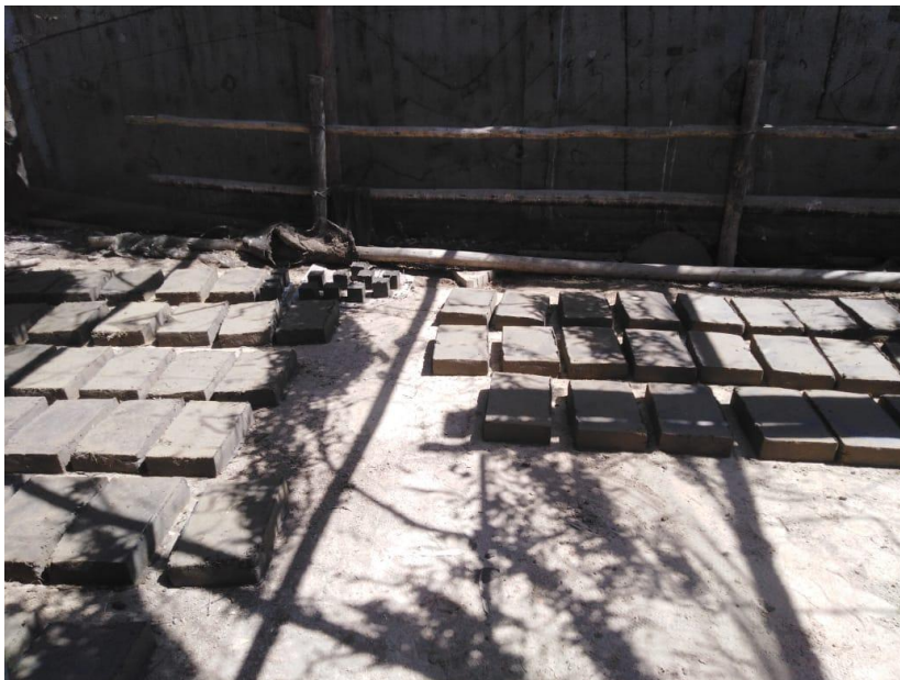
Figura N°20: Secado de adobes.
