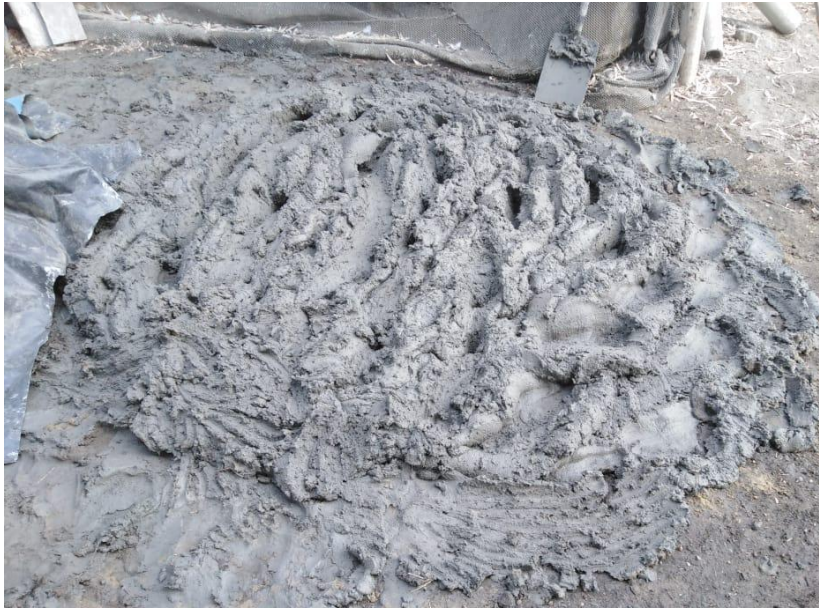
Figura N°5: Mezcla del adobe patrón.
