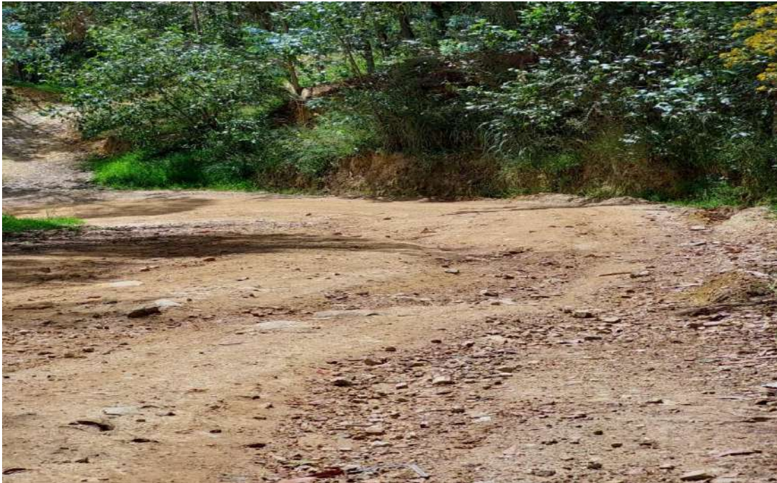
Figura 8: Situación actual de la carretera Rayme (KM 4+000), Cutervo, Cajamarca
