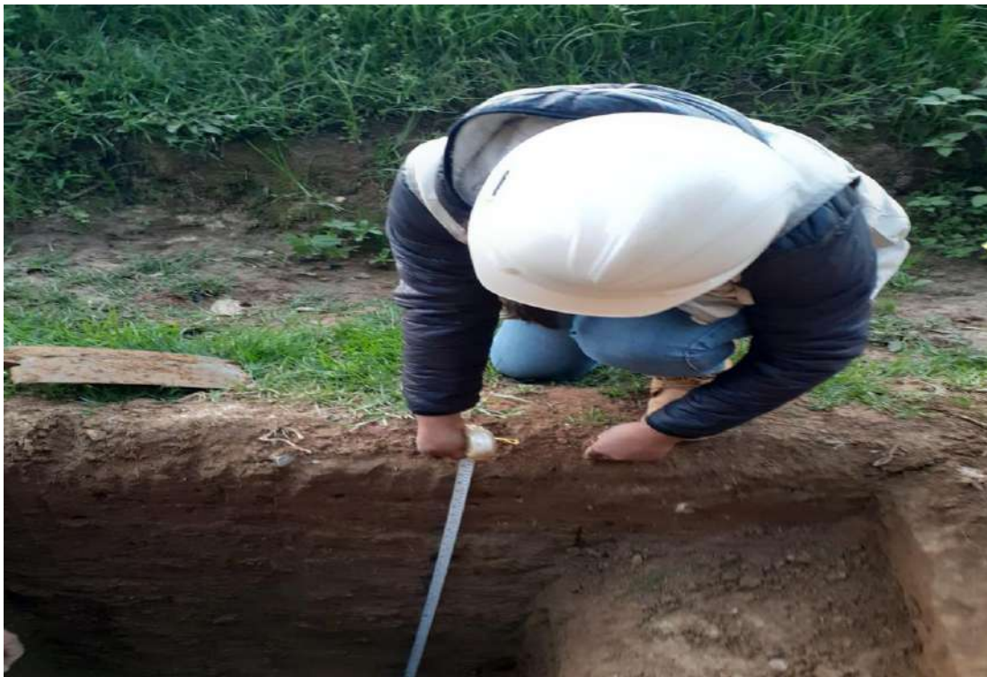
Figura 12: Carretera Rayme, Cutervo, verificación de profundidad de calicata N°3 (KM. 2+000)
