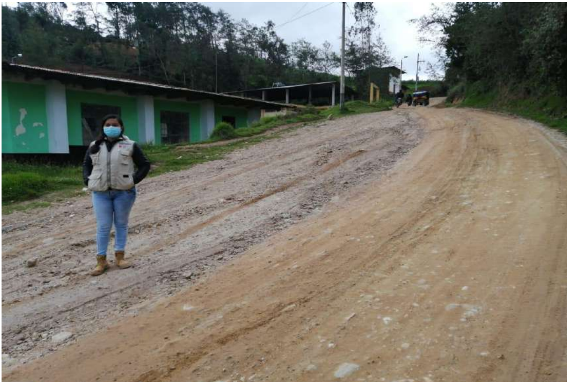
Figura 9: Situación actual de la carretera Rayme (km 3+000), Cutervo Cajamarca
