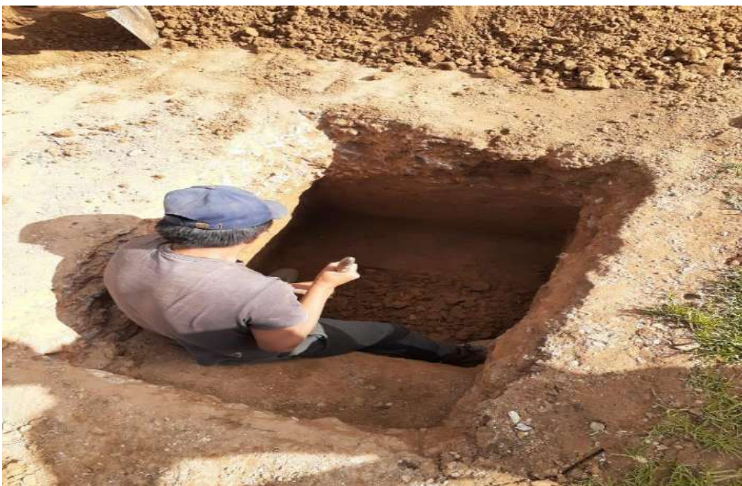
Figura 11: Carretera Rayme, Cutervo, Excavación de calicata N° 1 (km.0+00), 2021
