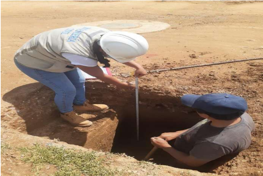
Figura 10: Carretera Rayme, Cutervo, Excavación de calicata N° 1 (km.0+00), 2021
