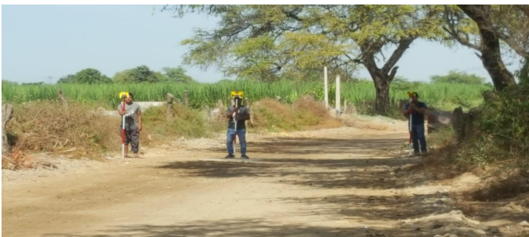
Ilustración 9. Vista panorámica del mal estado del Km 3+200
