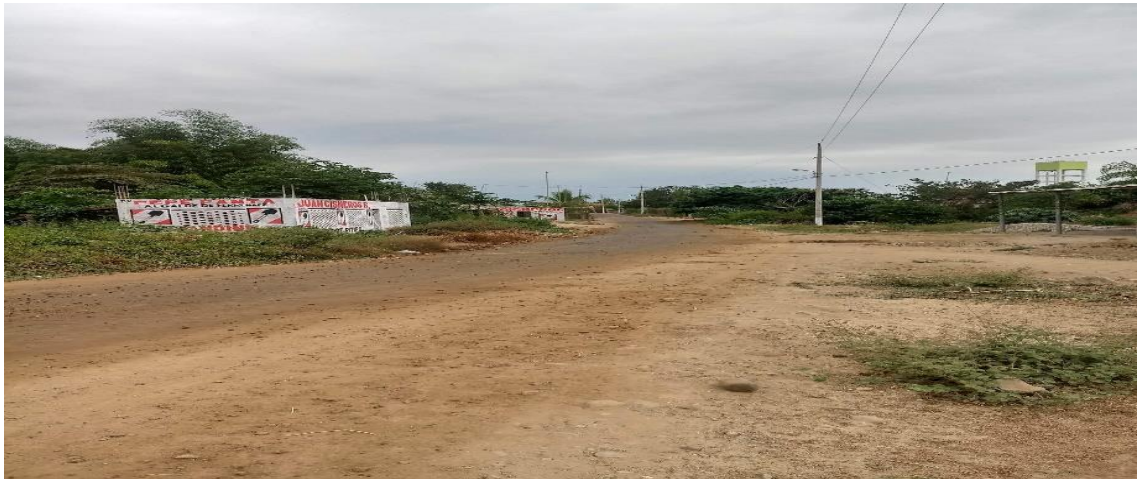
Ilustración 10. Vista panorámica de la longitud de curva a mejorar en trazo Km 4+637
