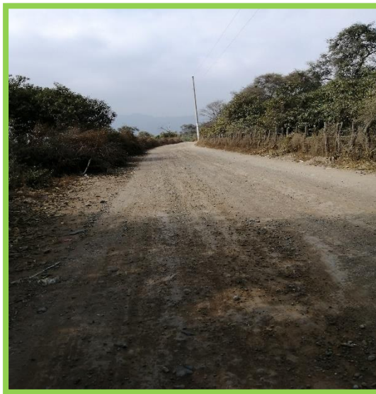
Foto N° 1: Curva existente sin señalización.
