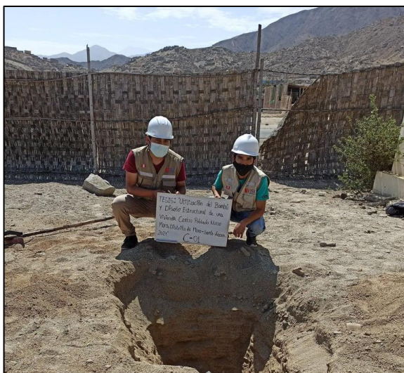
Foto N°5: Calicata realizada en el centro poblado Nuevo Moro
