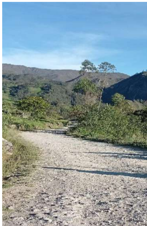
Figura 14: Situación actual de la carretera Peña Blanca, km 8, 2021
