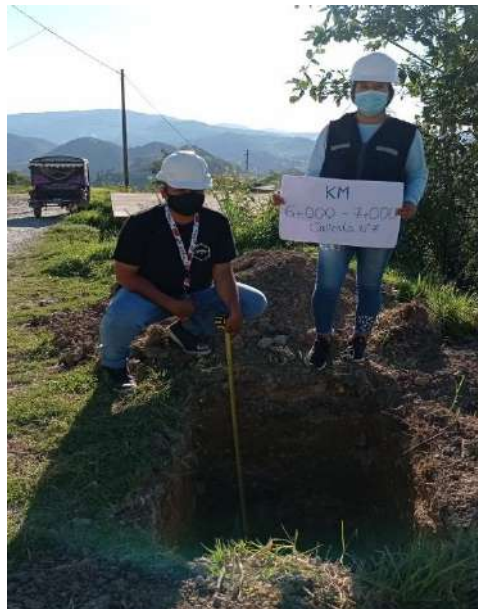
Figura 16: Carretera Peña Blanca, Tacabamba, Chota, Excavación de calicata N°7 (km.6+000-7+000), 2021.
