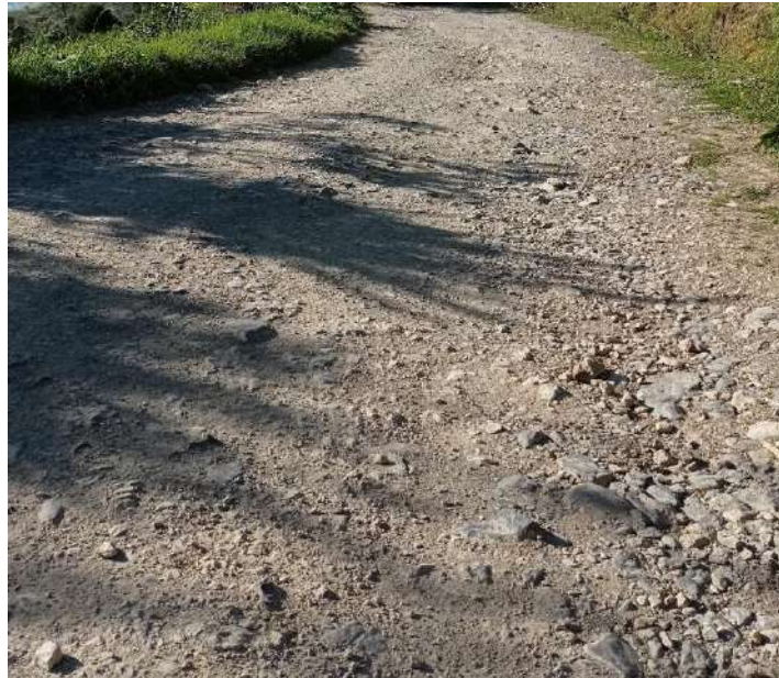
Figura 13: Situación actual de la carretera Peña Blanca, km 5+200, 2021.
