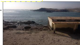
IMÁGENES 06: Viviendas Deshabitadas_ Elab. Propia
