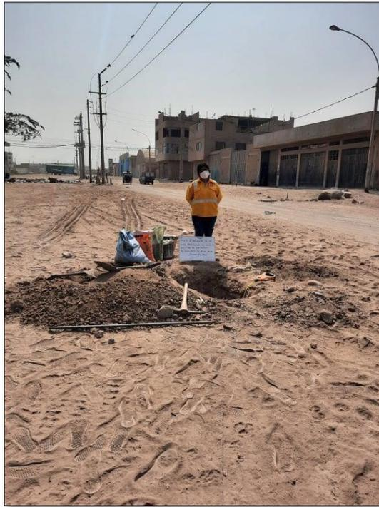
Figura 19. Extracción de la muestra (calicata a 1.5m de profundidad)
