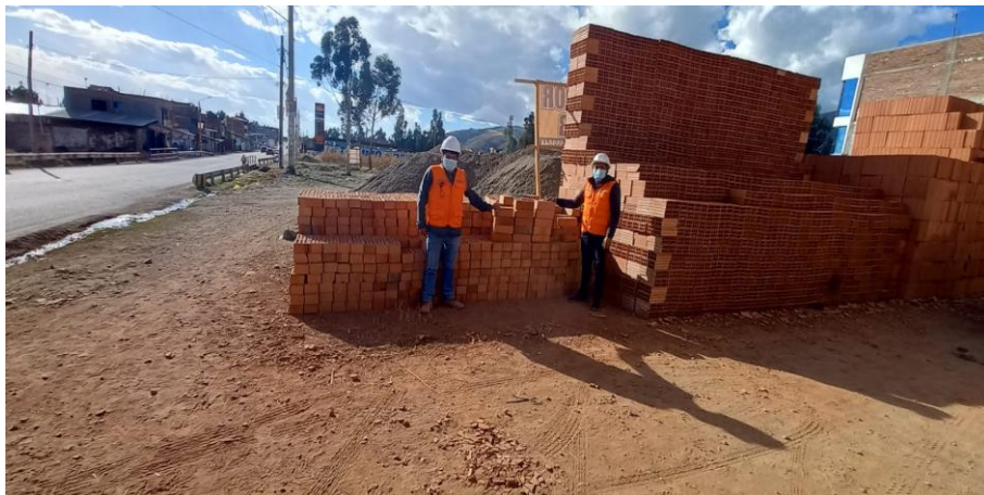
Verificando las unidades de albañilería
