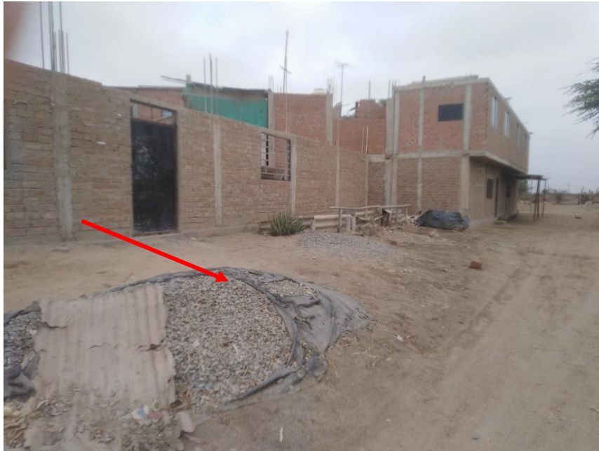
Fuente: imagen tomada por la avenida Ca. Manuel Sosa - Progresiva 0+280
