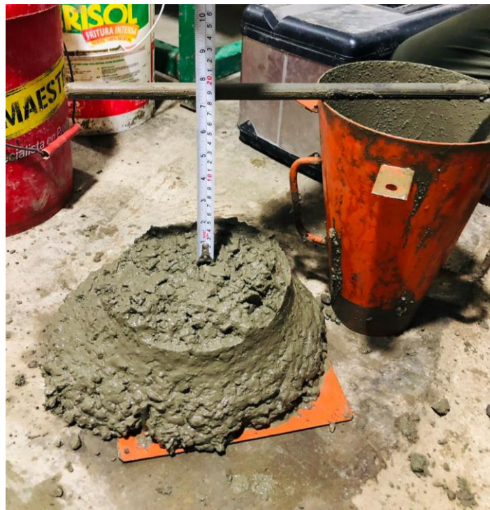
Anexo 8: Ensayo de Slump 7.5"
