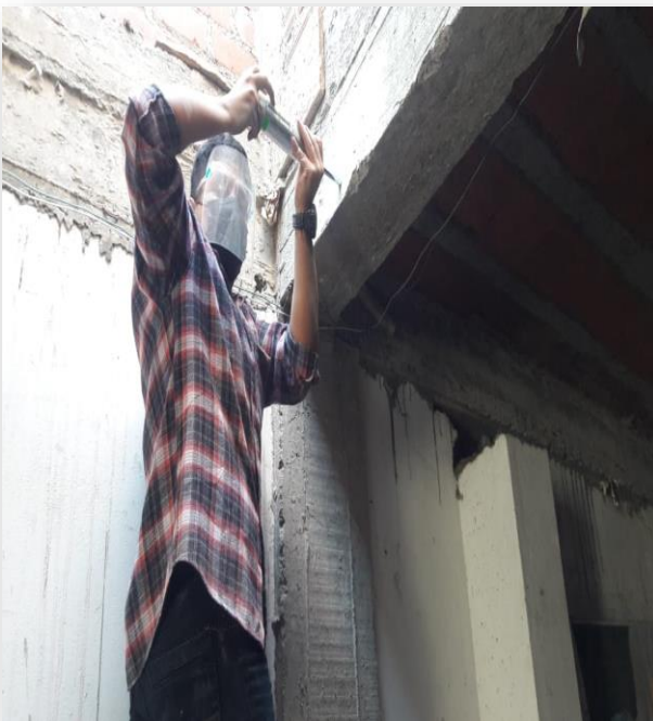
Figura 85. Ensayos viga vivienda 2.
