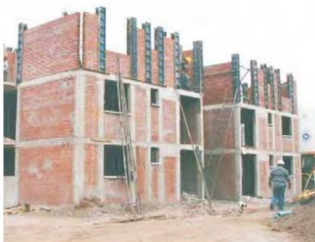
Figura 1. Albañilería confinada en proceso constructivo.
