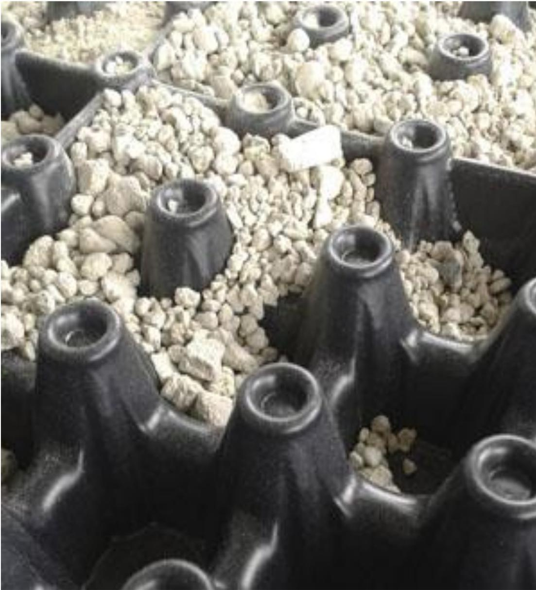
*Figura 6.*Capa de drenaje. Recuperado de: <https://www.projar.es/productos/productos-jardineria-urbanismo/cubiertas-ajardinadas/componentes-de-cubiertas-ajardinadas/laminas-drenantes/capa-de-drenaje-y-retenedora-de-agua-diadrain-40h-para-cubierta-semintensiva/>
