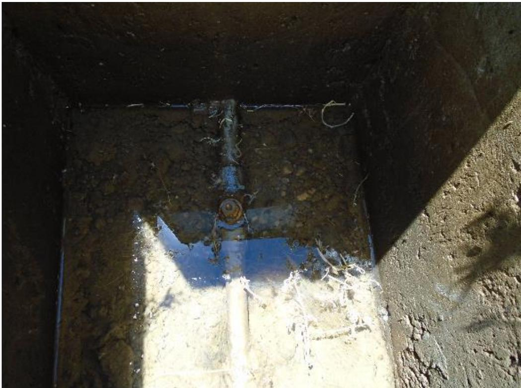
**Foto N°08:** Vista de las válvulas de control ubicadas en las redes de distribución que se encuentran deterioradas.
