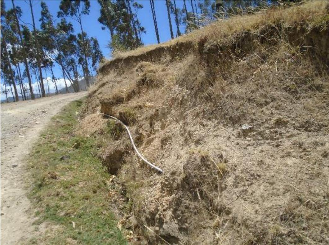
**Foto N°07:** Vista de la tubería expuesta en las redes de distribución.
