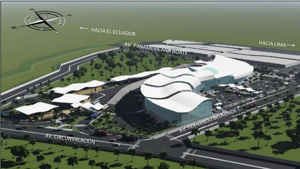
VISTA LATERAL SUR-ESTE
