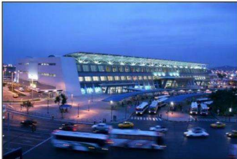
Figura 7. Terminal terrestre de Guayaquil
