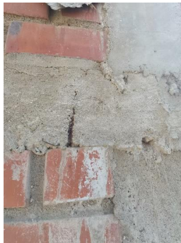
Anexo 35: Falta De Recubrimiento
