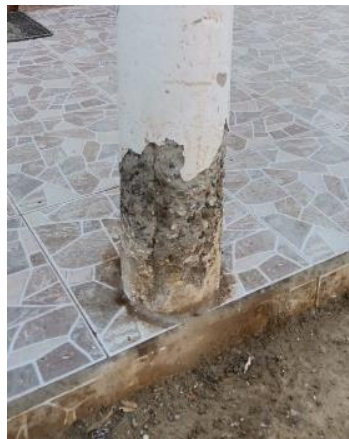
Anexo 38: Desprendimiento Del Concreto en columna circular
