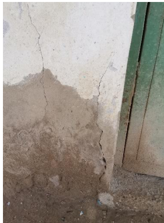
Anexo 35: Falta De Recubrimiento
