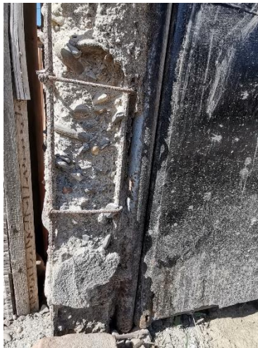
Anexo 38: Desprendimiento Del Concreto en columna circular
