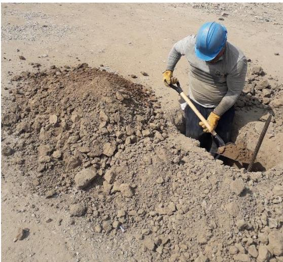
Fotografía 17. Excavación de la Calicata 2.
