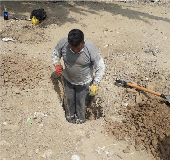
Fotografía 13. Excavación de la Calicata 1.
