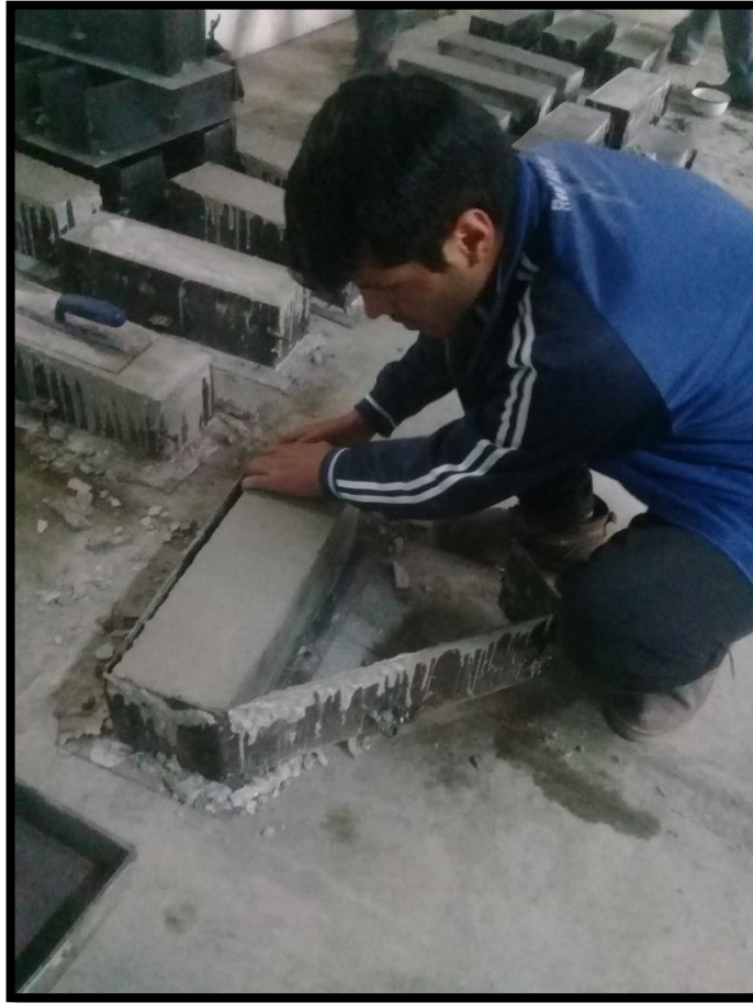
Foto N°35: Las viguetas desmoldadas
