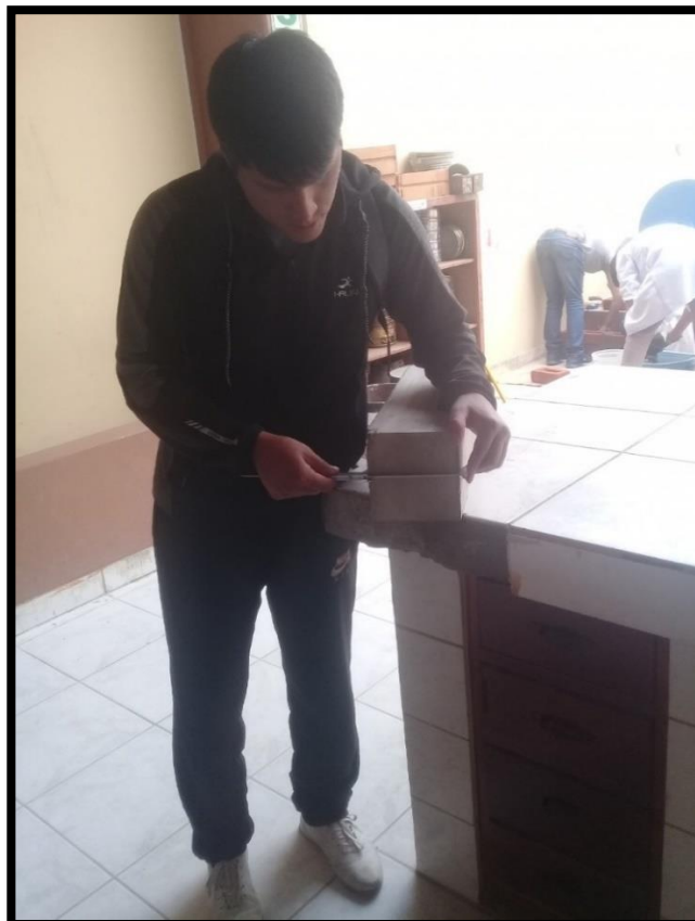
Foto N°41: Proceso de medición de las viguetas
