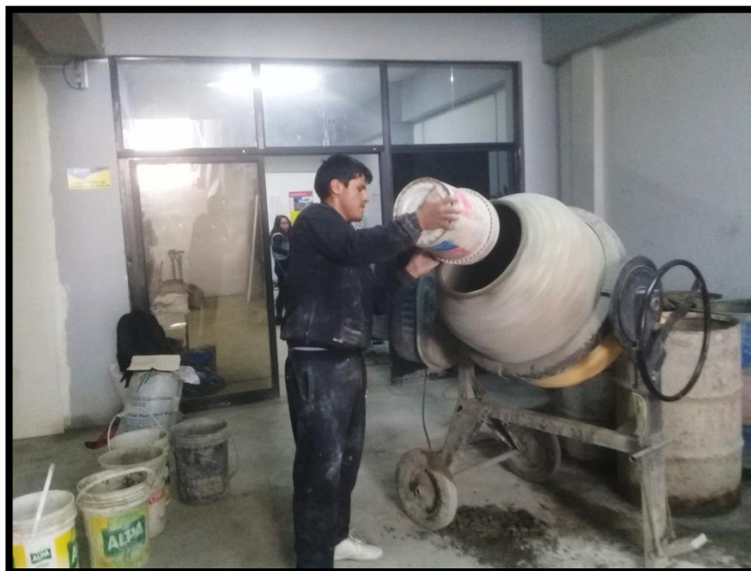
Foto N°31: Mezcla para dosificación
