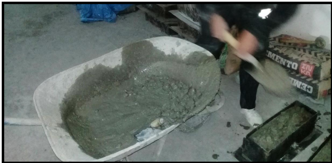
Figura 24: Vaciado de mezcla a los moldes
