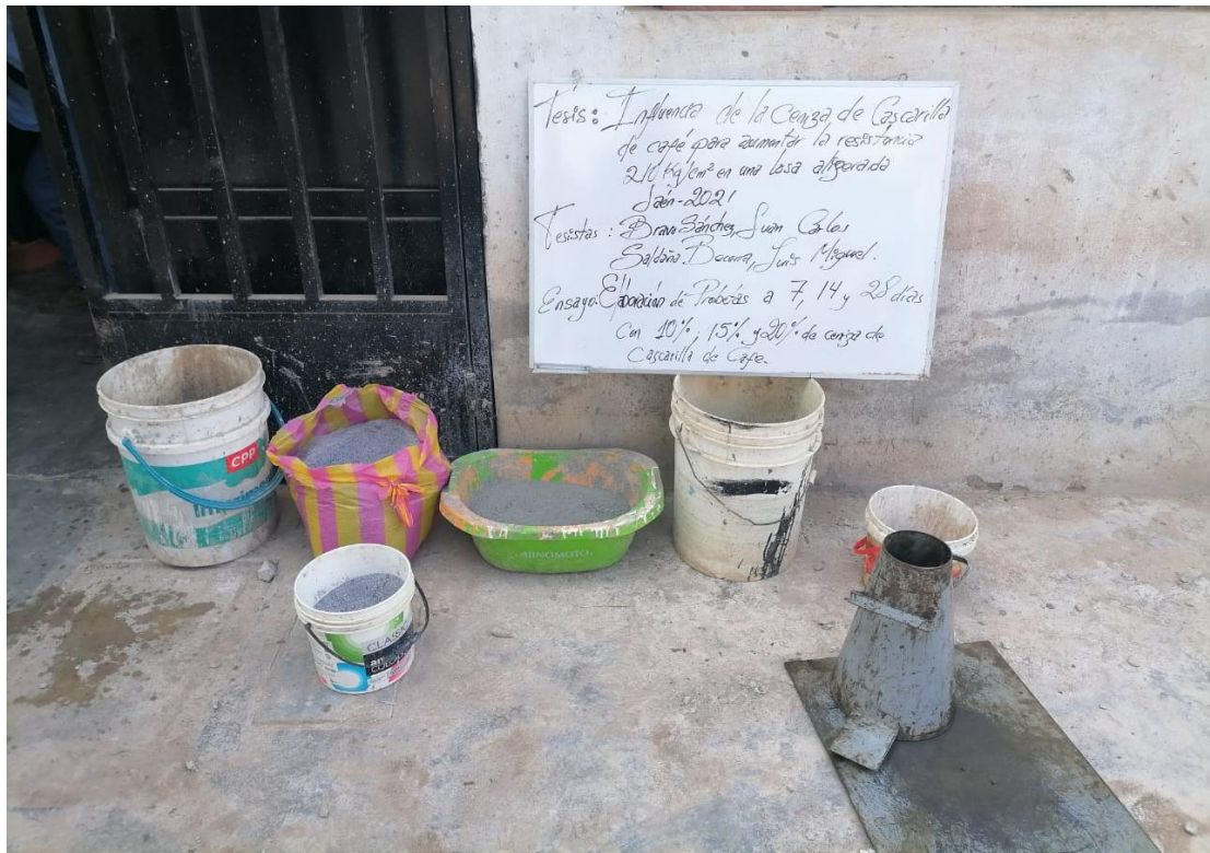
Figura N.º 4.7: Dosificación de los componentes del concreto
