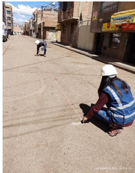
Foto N° 07 Fisuras en bloque, severidad baja.
