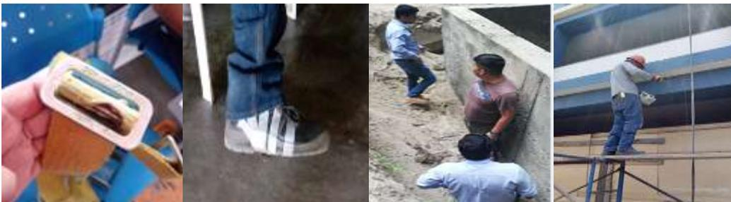
Adicionalmente a los puntos anteriores, las áreas de trabajo no cuentan con alguna determinada separación por área de trabajo, ya que todo está desordenado, no se cuenta con ruta peatonal, ni señaléticas de seguridad, las áreas están llenas de estructuras metálicas por diversas partes, donde no se evidencia el área de tránsito o ruta de evacuación.
