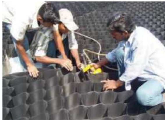
Figura 14. conexión de las unidades de geoceldas
