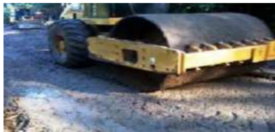
Figura 16. compactación de material de relleno
