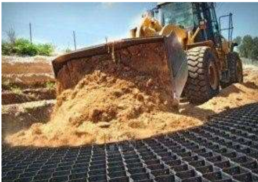
Figura 3. Aplicación de geoceldas eninfraestructura vial.
