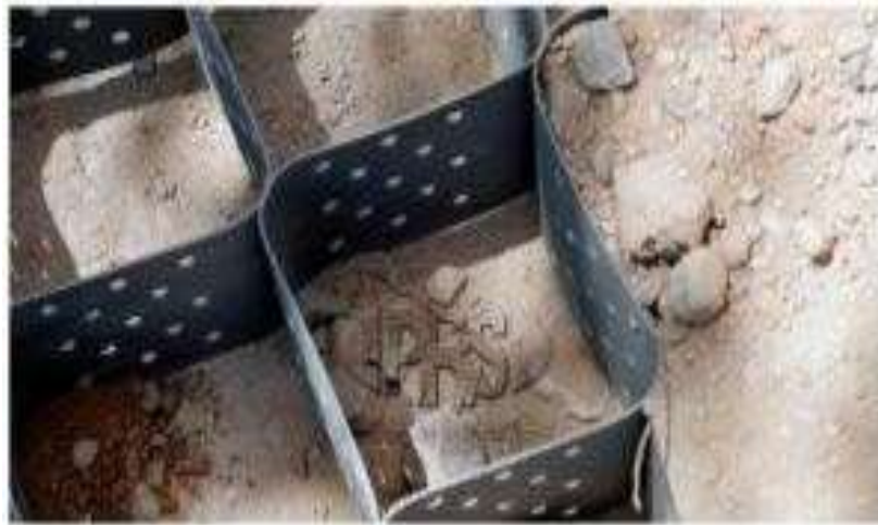
Figura 2. Estructura de una Geocelda
