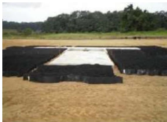
Figura 10. instalación de geocelda
