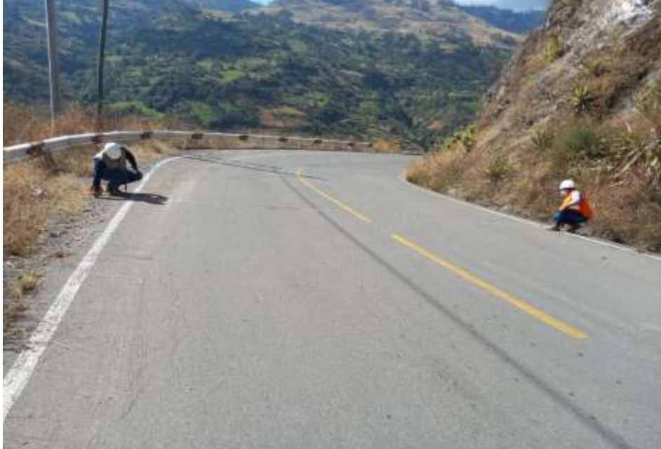
FOTO N° 05: Realización de medidas de plataforma de vía
