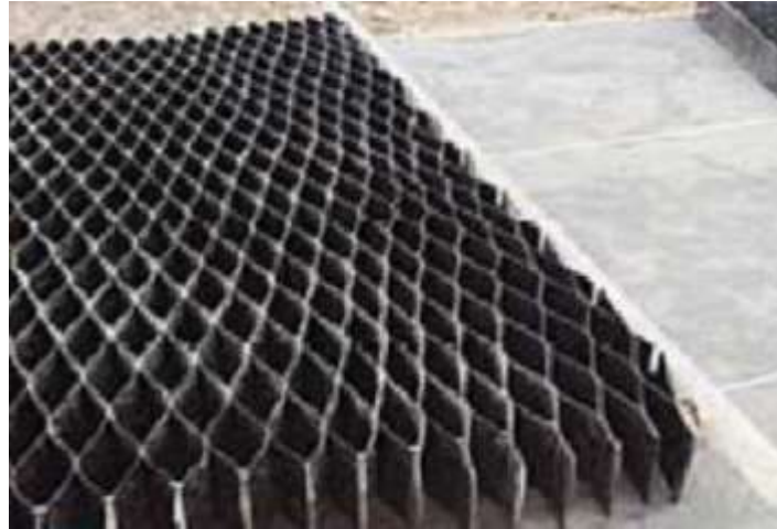
Figura 11. marco de instalación de geocelda
