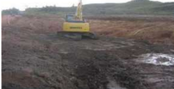
Figura 9 preparación del terreno
