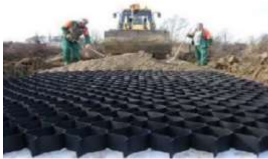
Figura 15.colocación material de relleno
