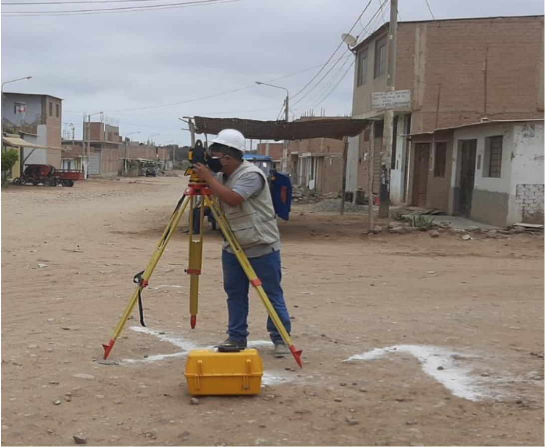
Figura 3: Radiación de puntos para obtener la forma de la superficie del terreno.
