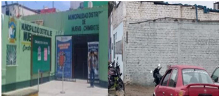
Figura 10: Escaneo de cimentación de la Municipalidad Distrital de Nuevo Chimbote.
