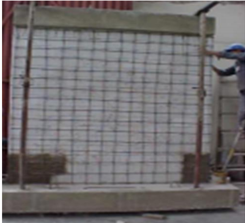
Figura 11. Reforzamiento de la estructura con malla electrosoldada propuesto por RNE.
