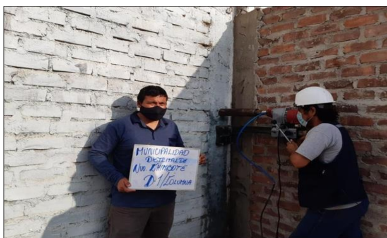
Figura 5: Extracción del núcleo de concreto, D-01 columna.
