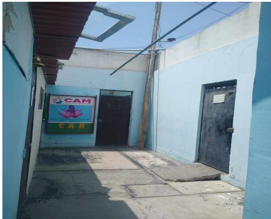
Figura 18. Parte no techada de la Municipalidad Distrital de Nuevo Chimbote.
