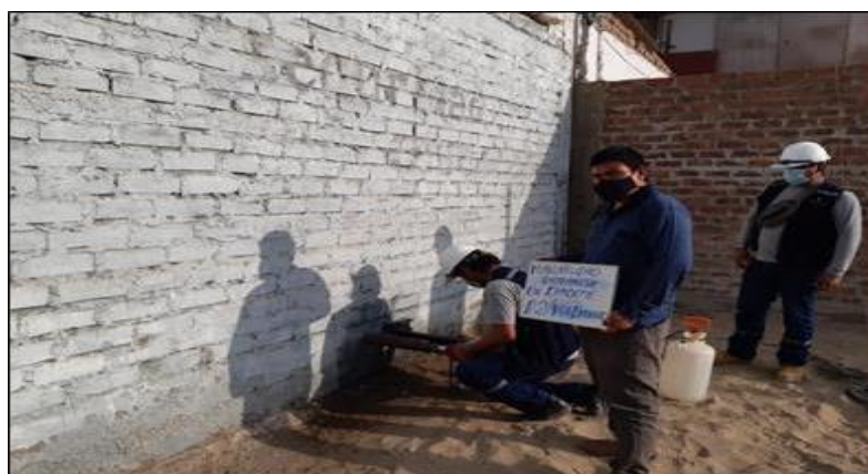
Figura 7: Extracción del núcleo de concreto, D-02 en viga de cimentación.
