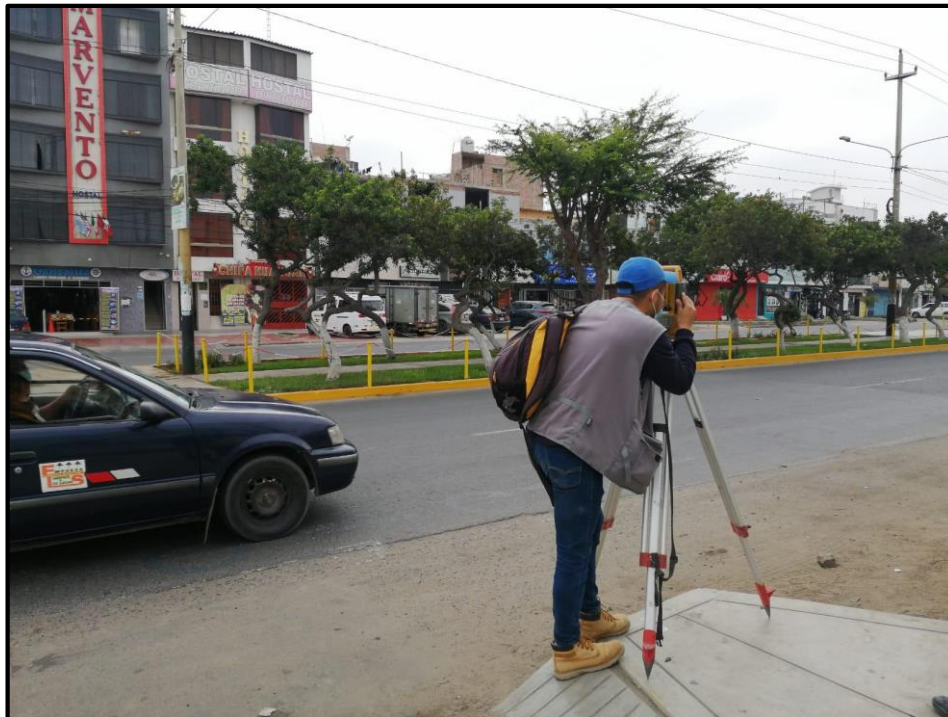
Figura 36. Se realizo el levantamiento topográfico con estación total.
