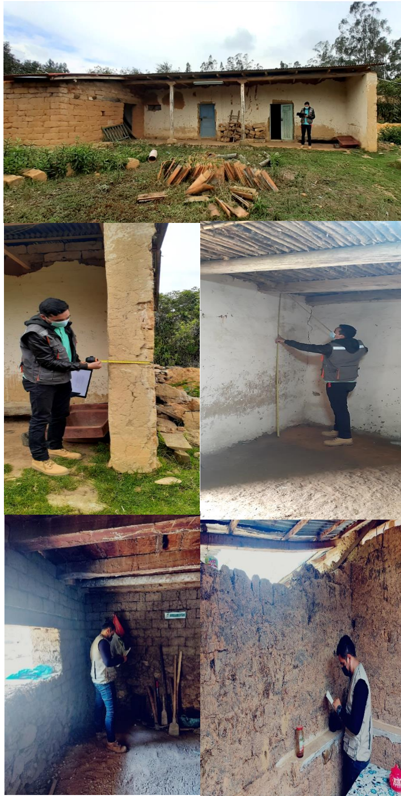
Figura 9: Registro de dimensiones de vivienda y constatación de materiales de construcción
