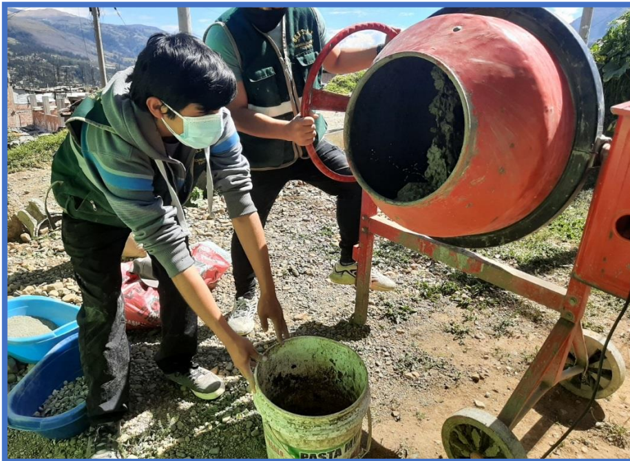
Imagen 35. Vaciado del concreto
