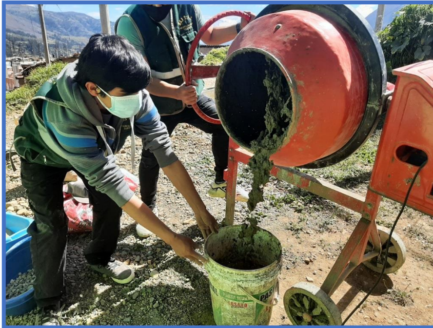
Imagen 366. Vaciado del concreto
