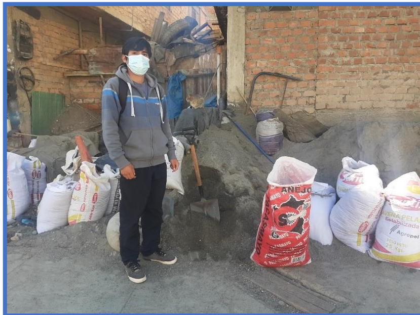
Imagen1y2.Recolección de agregado en la cantera de Tacllan.
