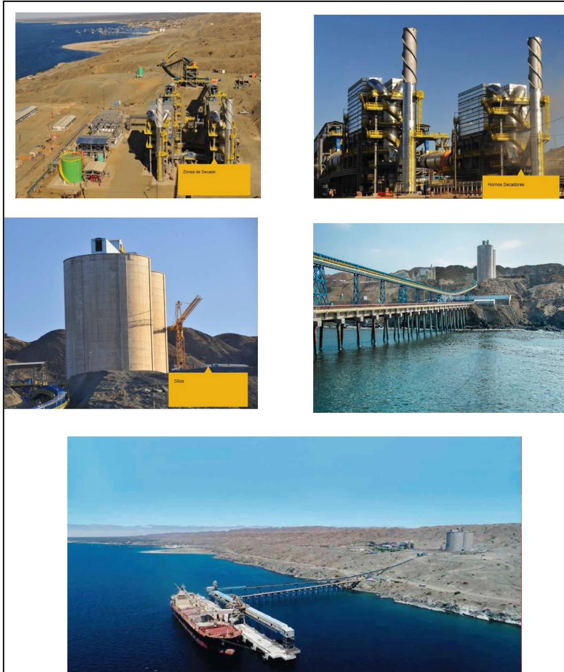
Figura 12. Planta de secado y silo de almacenamiento.
