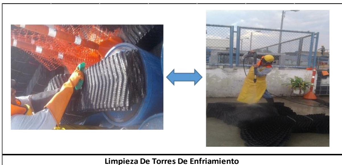
Figura 15: Limpieza de Torre de Enfriamiento.
